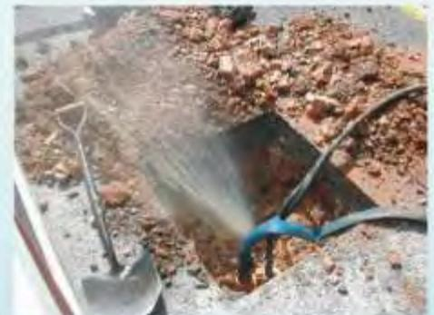
Fuga detectada (0.86 l/s) y priorizada con Leak Sizer.
