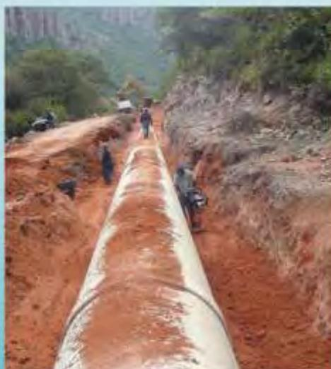
Durante la instalación se observó cómo el trabajo de diseño tuvo buenos resultados, aprovechando las posibilidades de deflexión proporcionada en cada unión de nuestra tubería, adaptándose a lo sinuoso y escarpado del terreno y ahorrando la instalación de codos.
