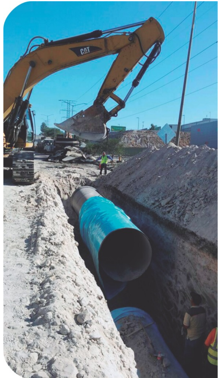
Reposición del Acueducto Florido-Aguaje.
