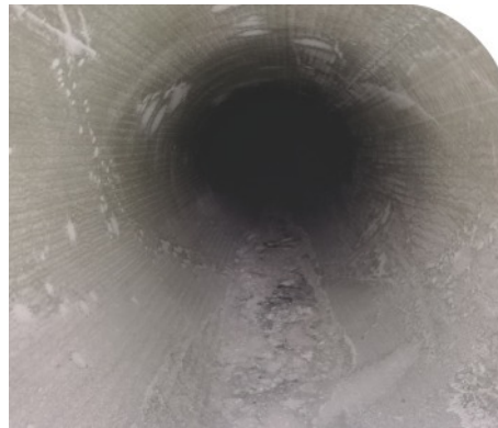
Vista tubería rehabilitada CIPP-UV.
