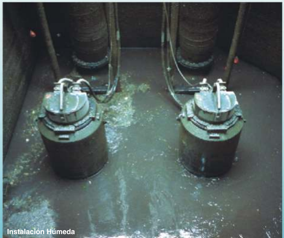
Impulsores Super Vortex: Diseño patentado de GRUNDFOS , mejora la eficiencia y evita atascos en la operación del equipo.
