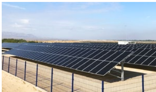
Figura 2. Vista diagonal Este.
