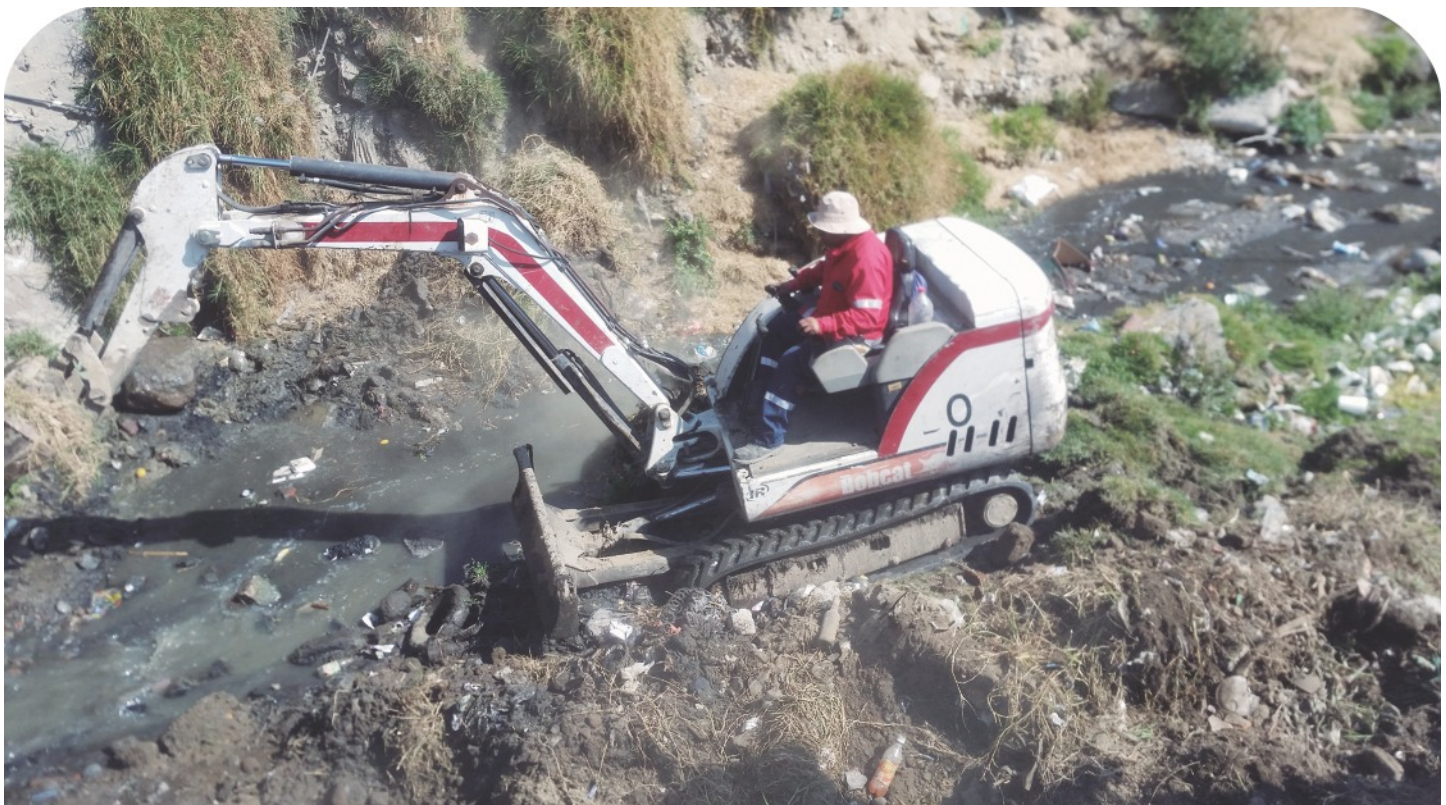
Desazolve arroyo Agua Bendita.
