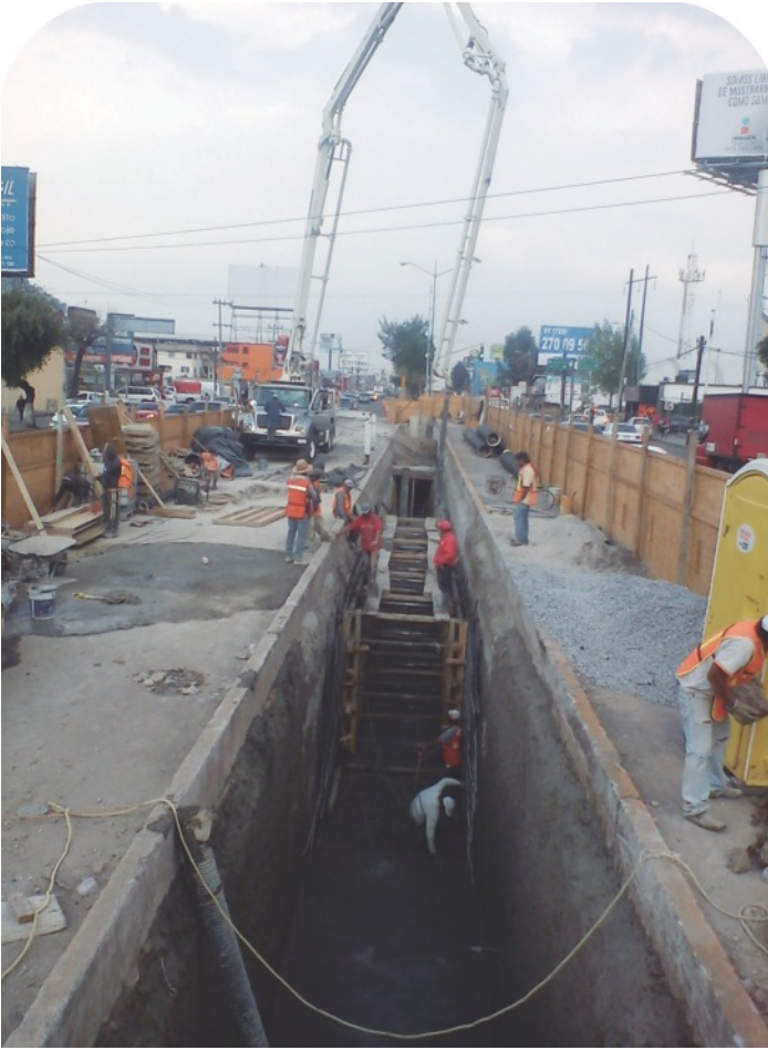
Construcción de pozo de absorción.
