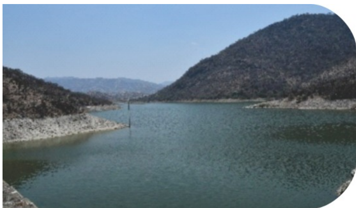
Vista general de la presa.
