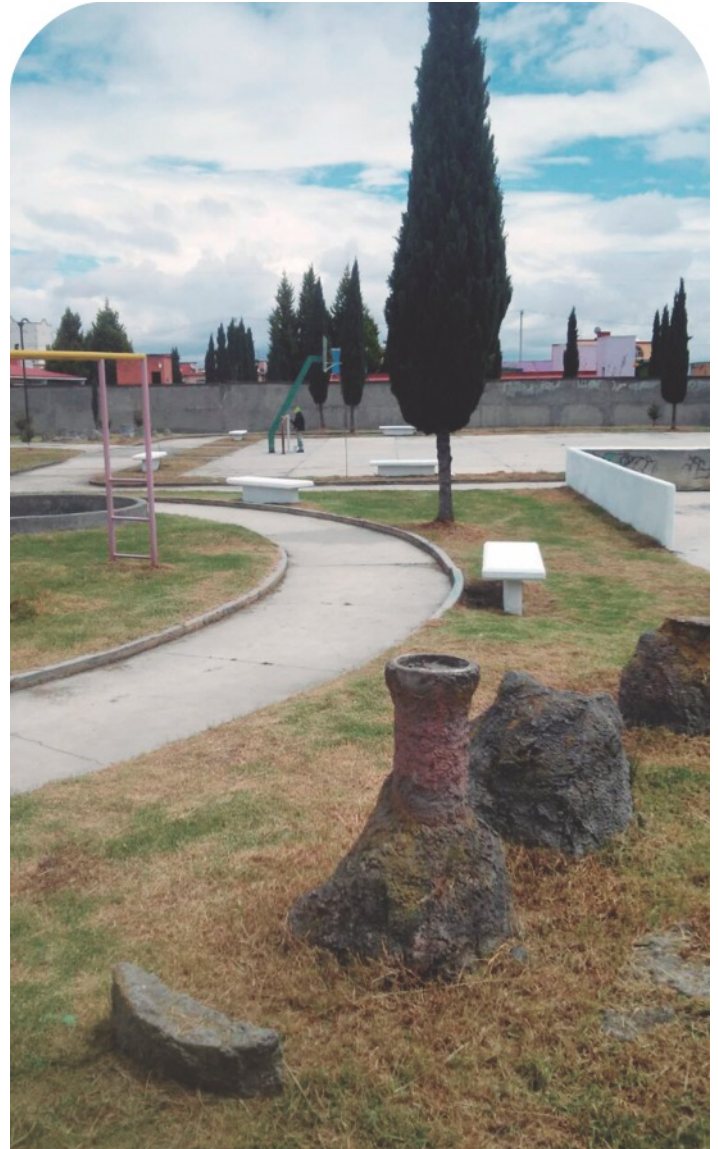
Infiltración en Paseos del Valle.
