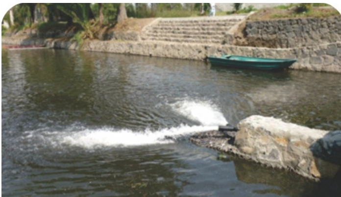
Embarcadero de Atenco después de la instalación de tubería.
