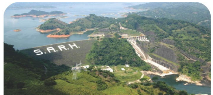
Central hidroeléctrica Angostura, Chiapas.
