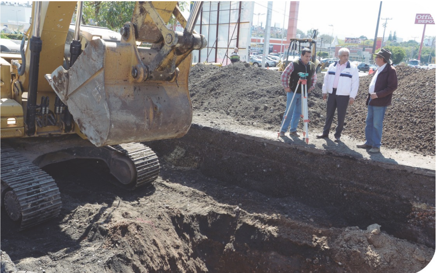
Construcción del colector sanitario "Santa María-Casa de Gobierno-río Grande".
