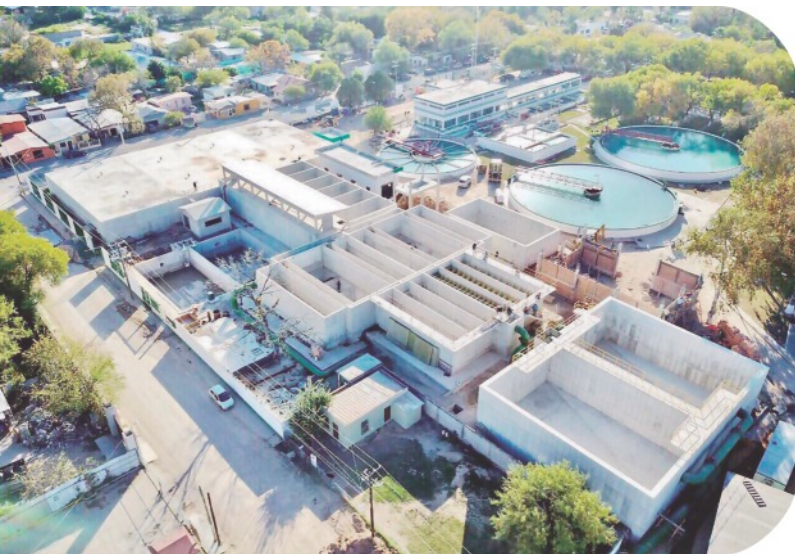
Vista de la obra civil de la tercera planta potabilizadora.
