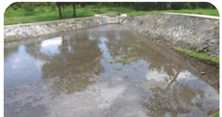
Redondel con agua tratada.
