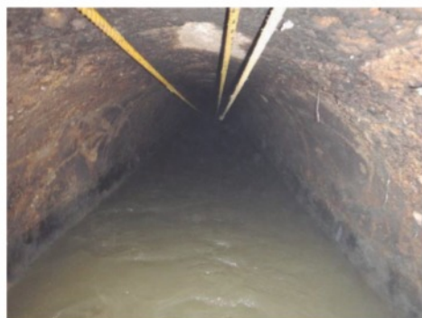
Colector 60"Ø desazolvado para su rehabilitación
