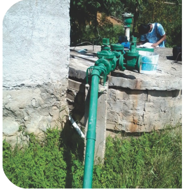
Evaluación de las condiciones actuales de operación y de los usos de agua.
