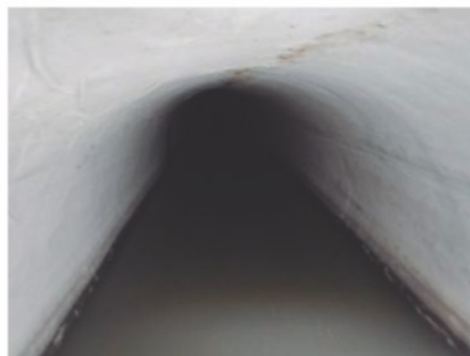
Colector 60"Ø Rehabilitado por método CIPP
