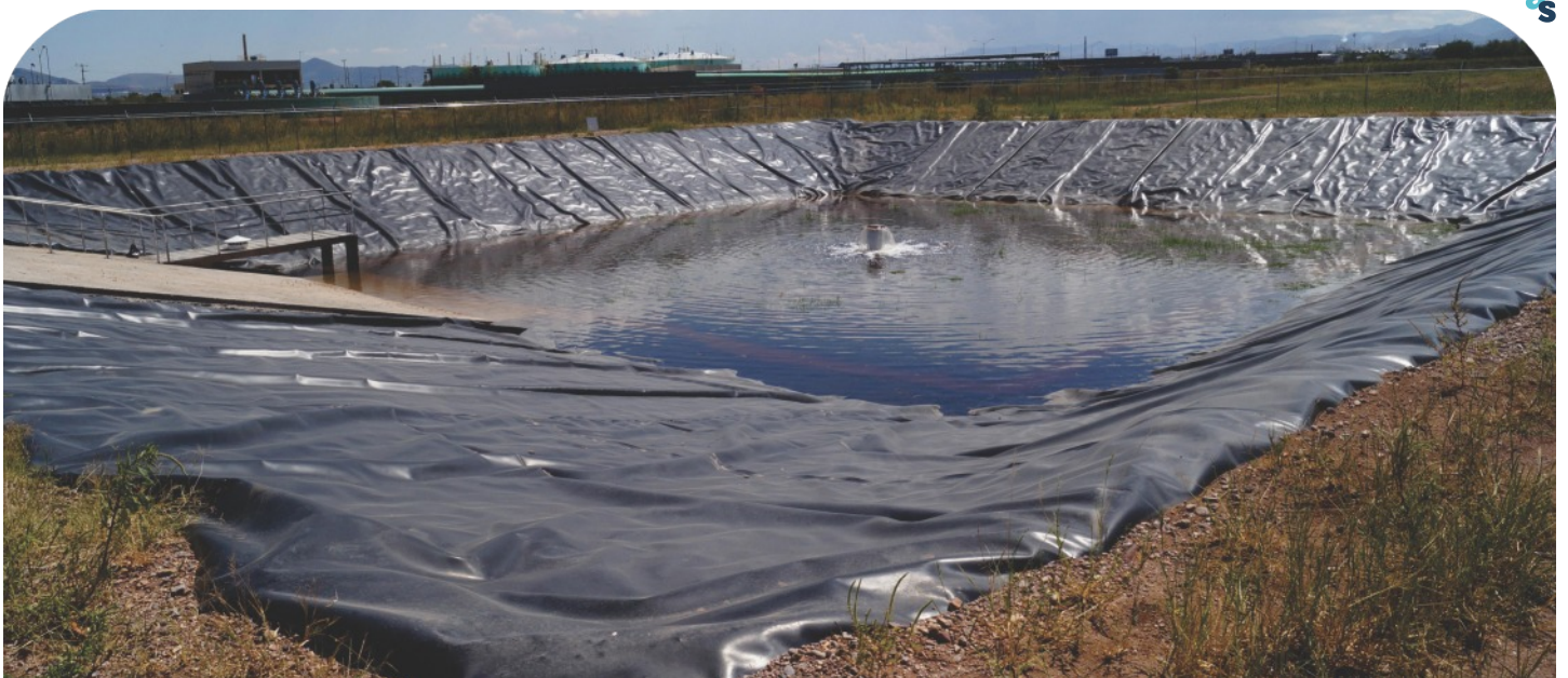
Figura 7. Balsa de infiltración.
