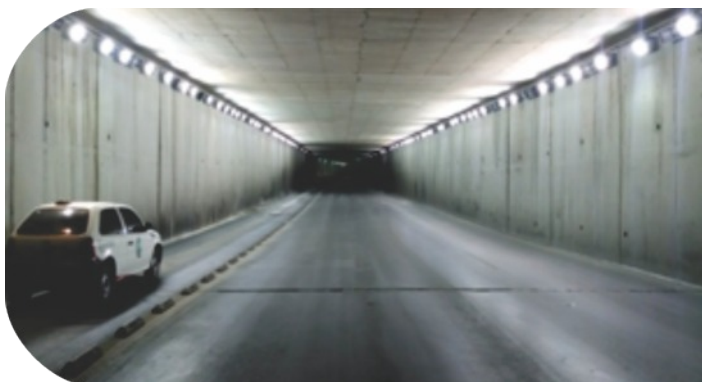
Figura 5. Estacionamiento del Congreso del Estado y el túnel de la Independencia antes y después de la sectorización.
