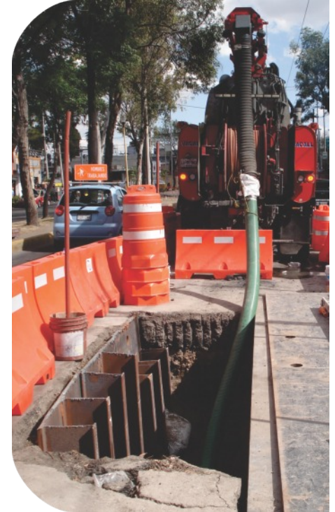
Vista desde caja de acceso y trabajos de desazolve.
