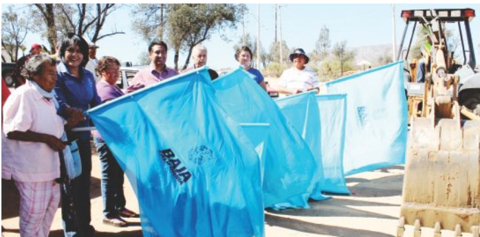
Inicia la obra de reposición del acueducto Carrizo Cuchumá.
