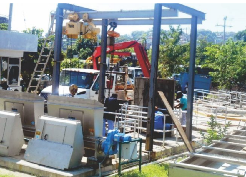
Retiro de arena acumulada de la PTAR Aguas Blancas.
