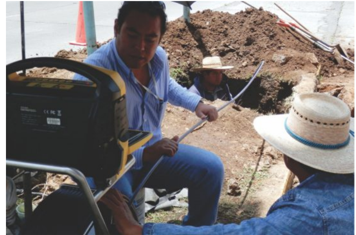
Detección de fugas.
