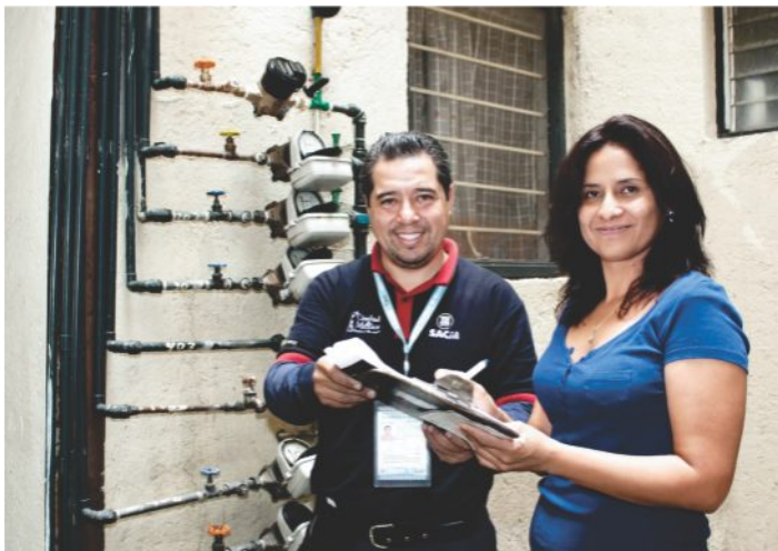
Instalación de medidores.
