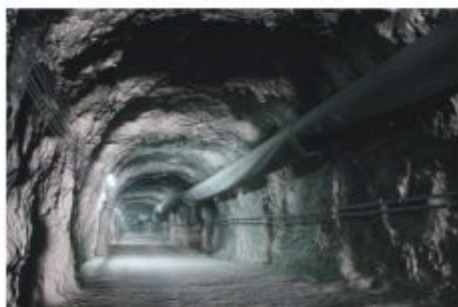
Vista interior con ducto de ventilación.
