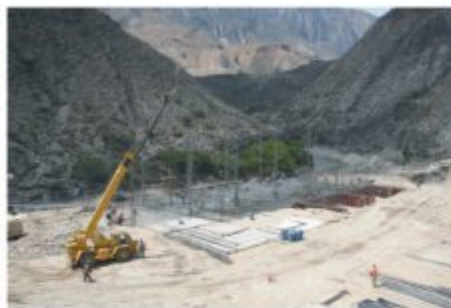
Cimentación de la estructura para la planta de bombeo 1.
