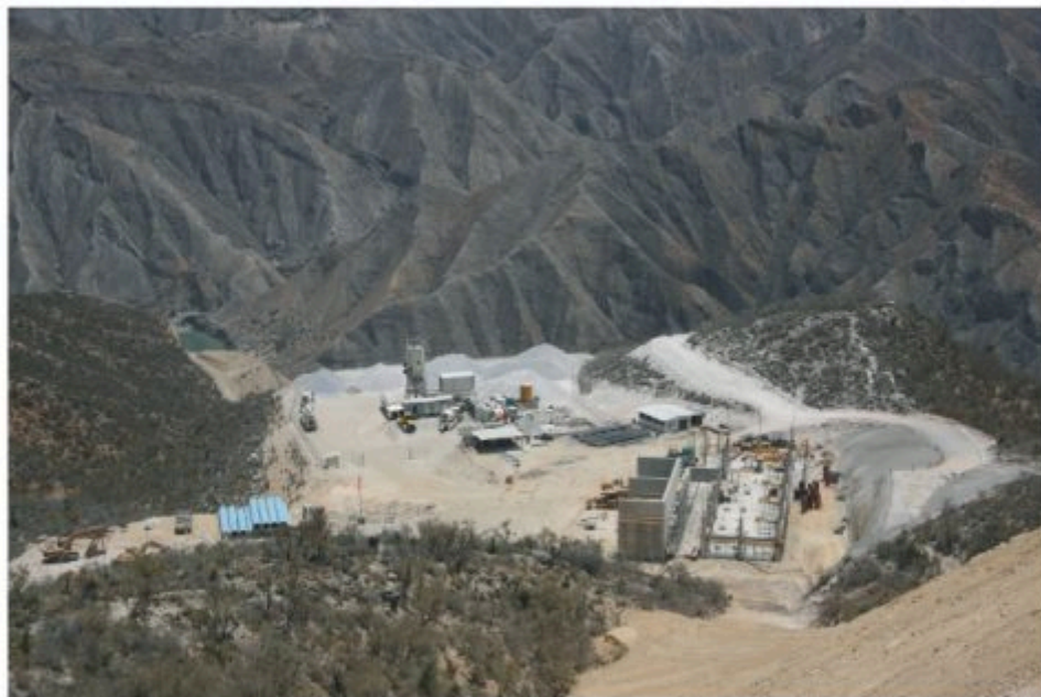
Construcción de la estructura de la planta de bombeo 2.
