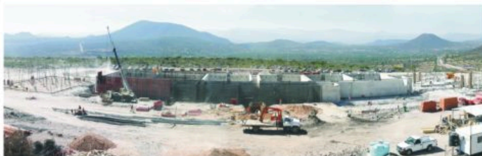
Construcción de edificios de la planta potabilizadora.
