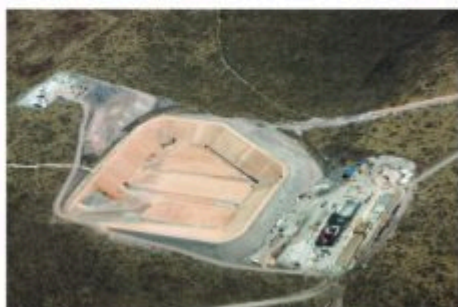
Vista de conjunto del bordo de seguridad y la planta potabilizadora.
