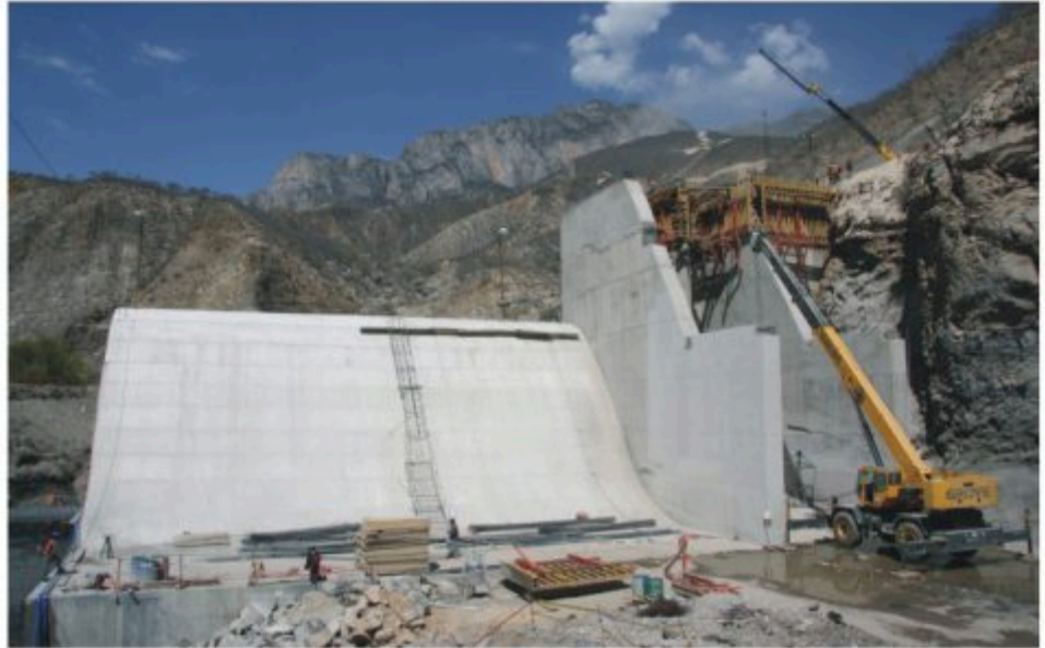
Construcción de la cortina y del canal de limpia de la presa derivadora.
