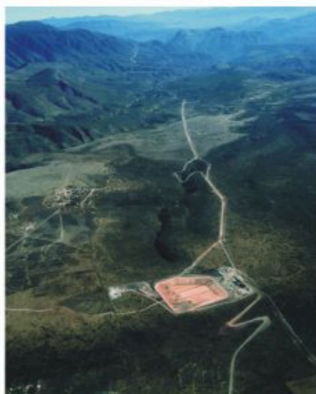
Panorámica bordo de seguridad y trazo de línea de conducción.
