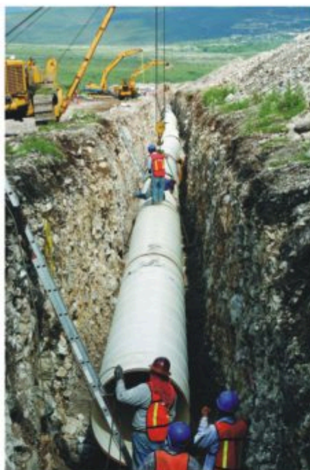
Instalación de tubería de acero en tramo de impulsión.
