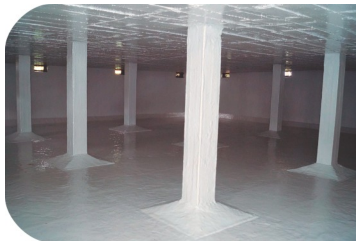
Los trabajos de rehabilitación incluyeron resanar fisuras y aplicación de vitroacero.
