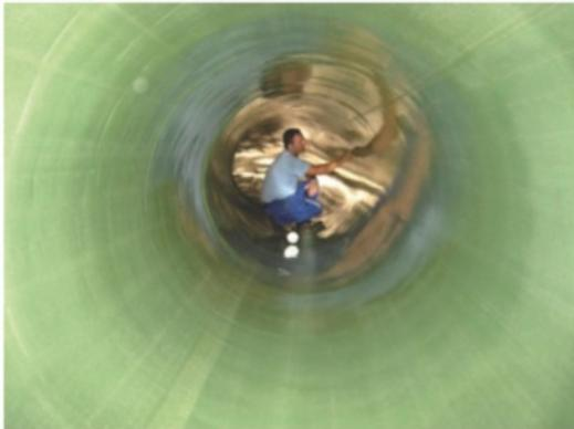
Tubería con refuerzo de fibra de vidrio y curado por UV
