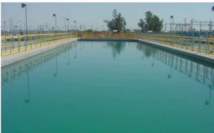
Planta potabilizadora Xochimilco de CESPM .
