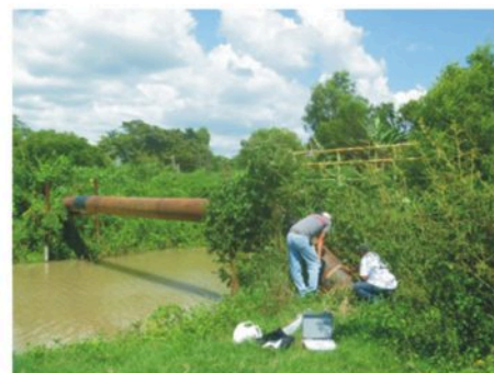
Ilustración 2. Medición de caudal en tubería de acero, en los cruces especiales.
