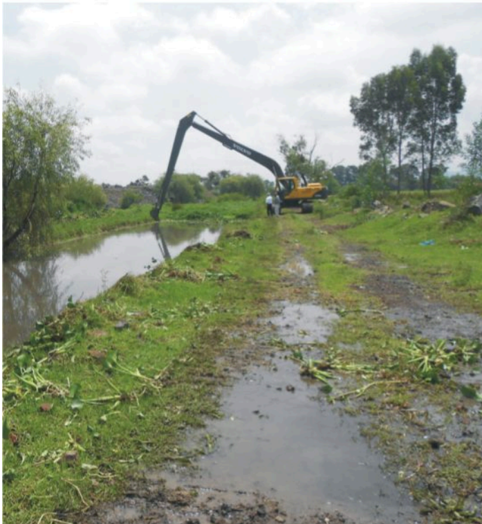
Limpieza del dren Itzícuaros.
