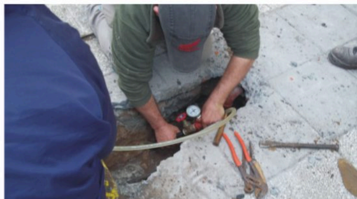
Imagen de Stock: Instalación de medidores en un condominio.
