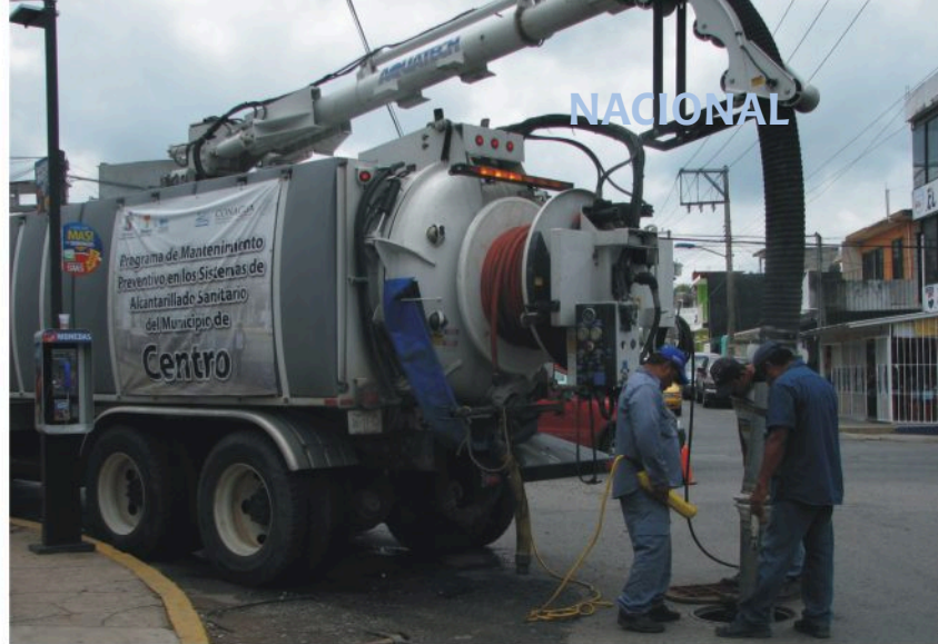
Desazolve de la Av. Gregorio Méndez, Col. Tamulté, en Villahermosa, Tabasco.
