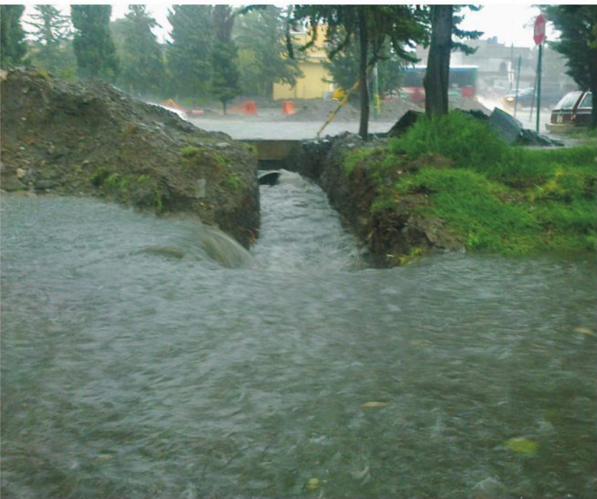
El canal de desfogue realizado en el cruce de las Avenidas Margaritas y Camino Nacional funcionó y aminoró una mayor inundación en la zona.
