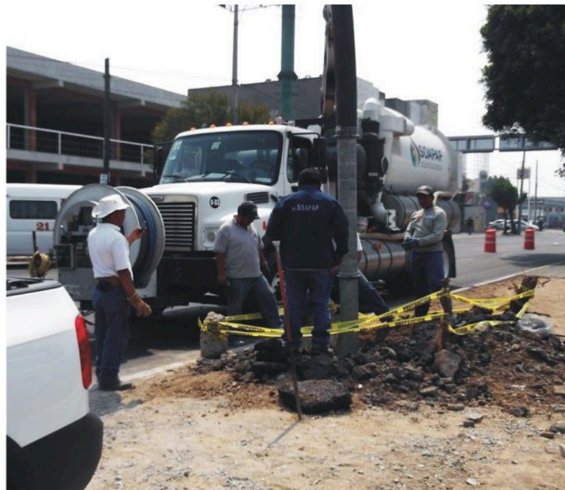
Personal del SOAPAP , con el apoyo de una unidad hidroneumática, desazolva un tramo de la red general de drenaje.
