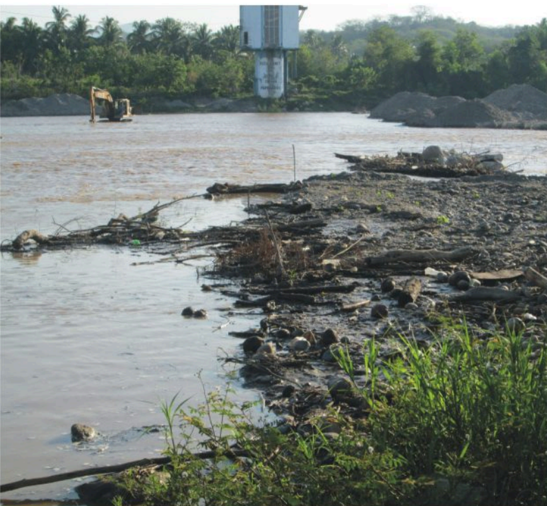
CAPAMA realiza labores de limpieza en el Sistema Papagayo II.
