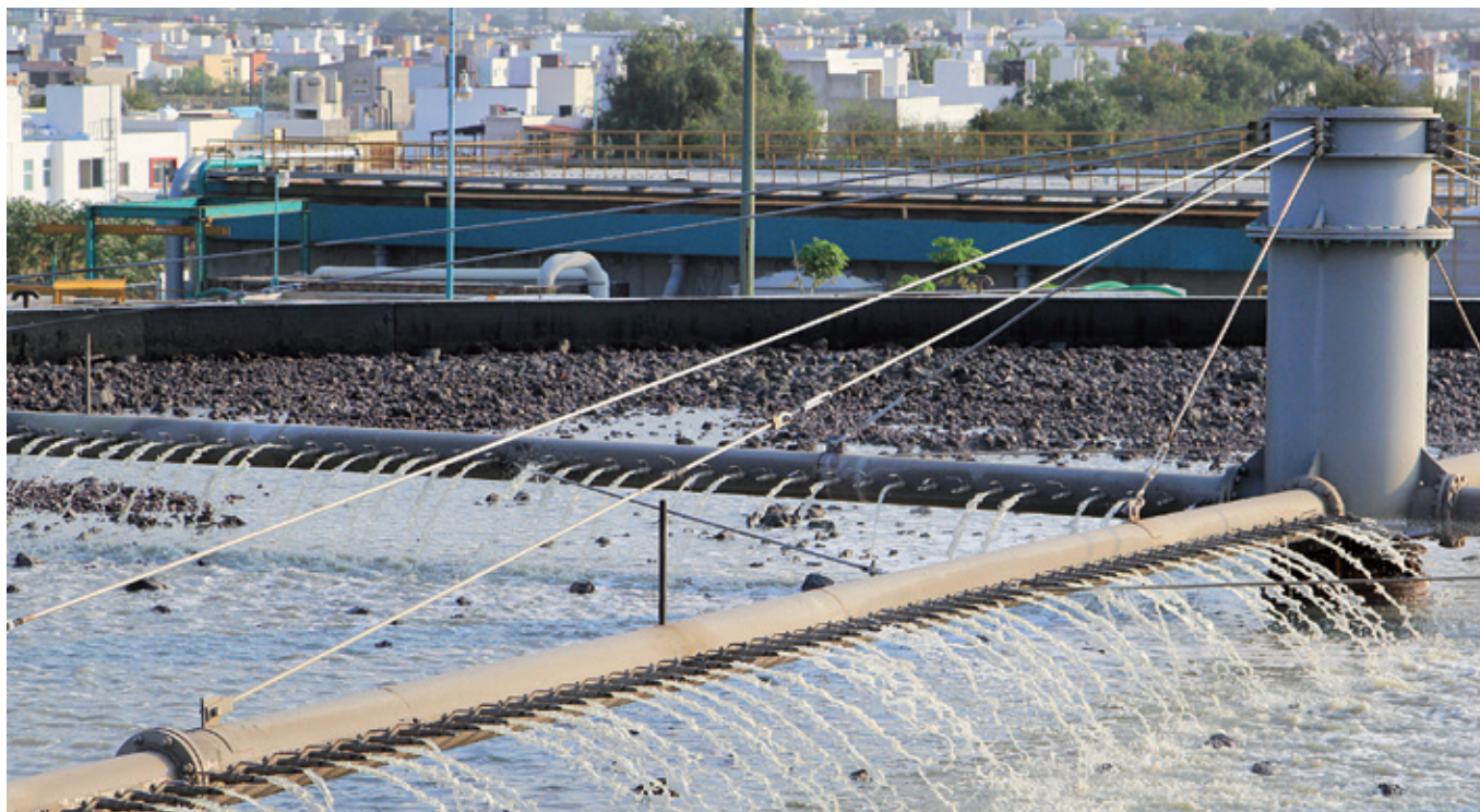
La reducción del rango de inversión nos obliga a replantear las prioridades en materia de obra pública.
