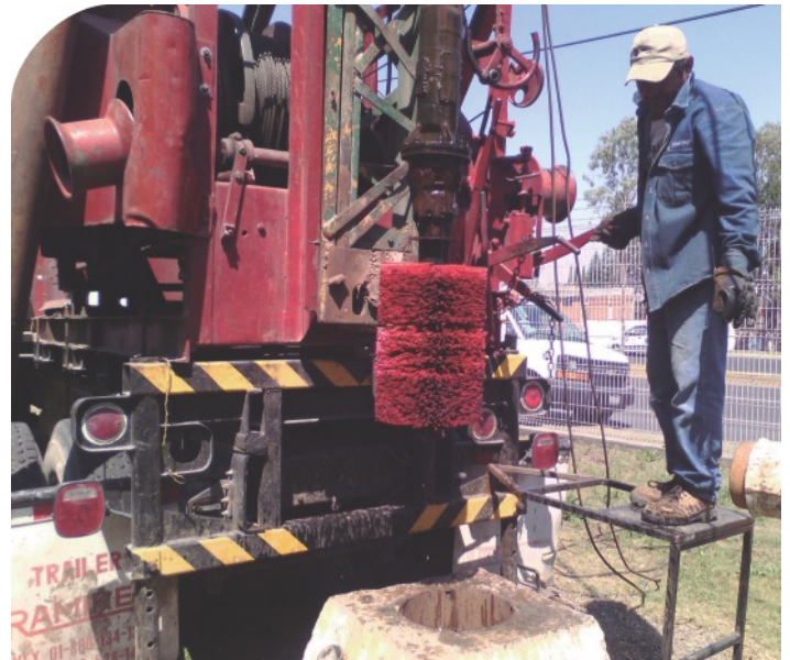
Rehabilitación de pozos.
