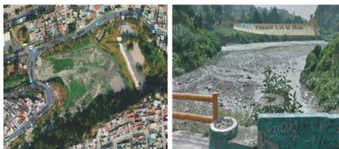
Se observan vertederos de basura en las márgenes del embalse con mayor acumulación en la obra de toma y en la cortina de la presa San Francisco, colonia Jalalpa, CDMX. Imágenes Google Maps.
