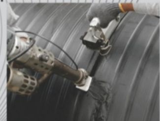
Unión por termo-extrusión con material de aporte.
