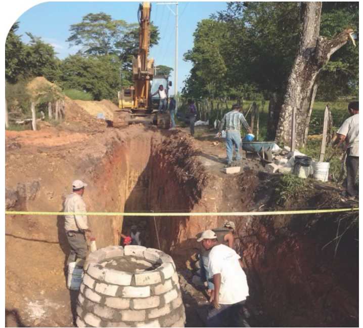
Se realizaron obras de drenaje sanitario en el municipio de Tenosique.
