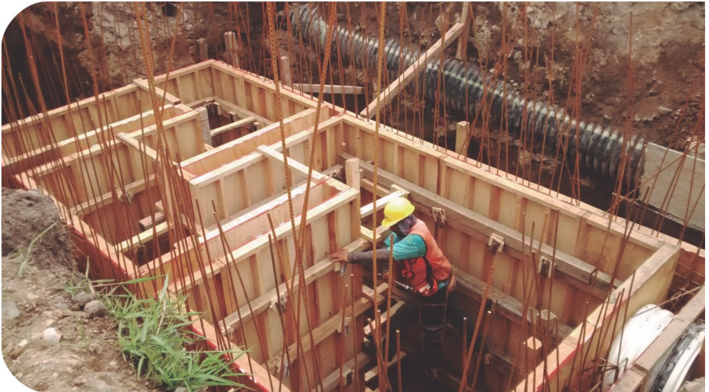
Ampliación de planta de tratamiento de aguas residuales de Atlixco.
