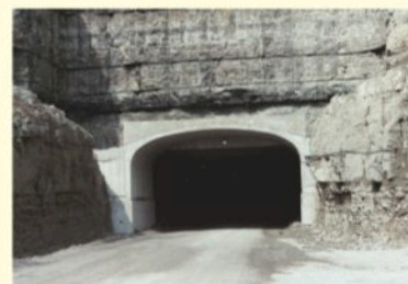
CON/SPAN arcos prefabricados para su uso en aplicaciones industriales del túnel
