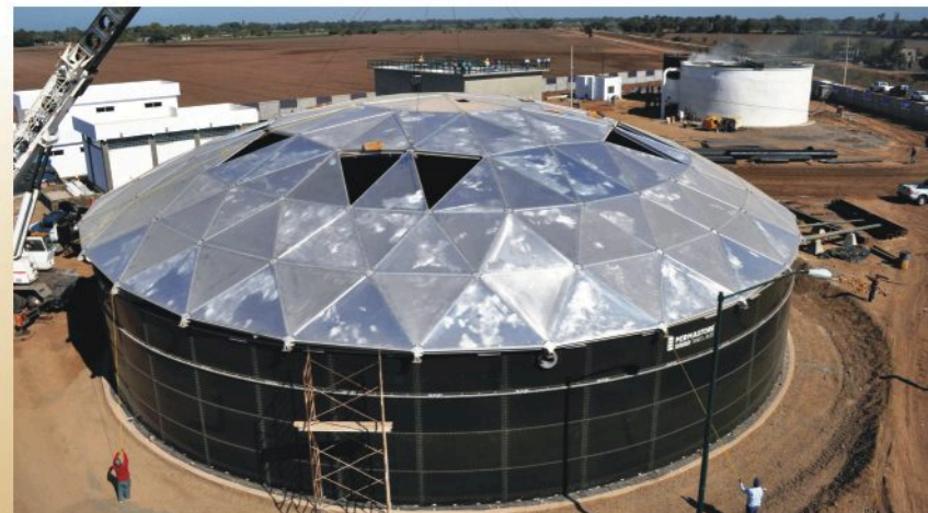
Colocación del domo al tanque regulador de 500 lps.
