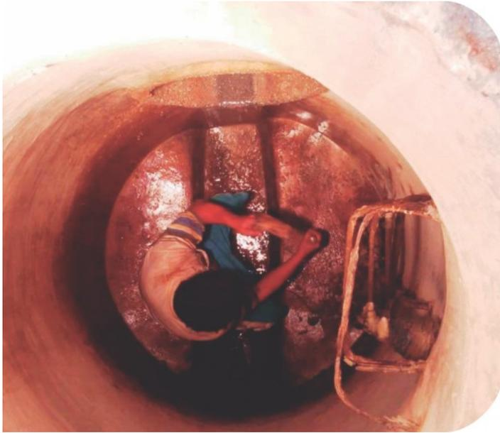
Rehabilitación de 100 metros lineales a la red de drenaje de 12 pulgadas de diámetro.
