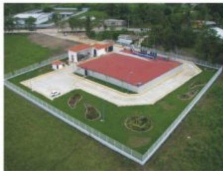
Además, se realizó la obra de edificación de dos módulos de 500 lps en la planta potabilizadora, dentro del área donde existía el primer módulo de 500 lps, con lo que la capacidad final de esta planta alcanzó 1,500 lps.
