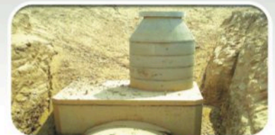
POZO DE VISITA
