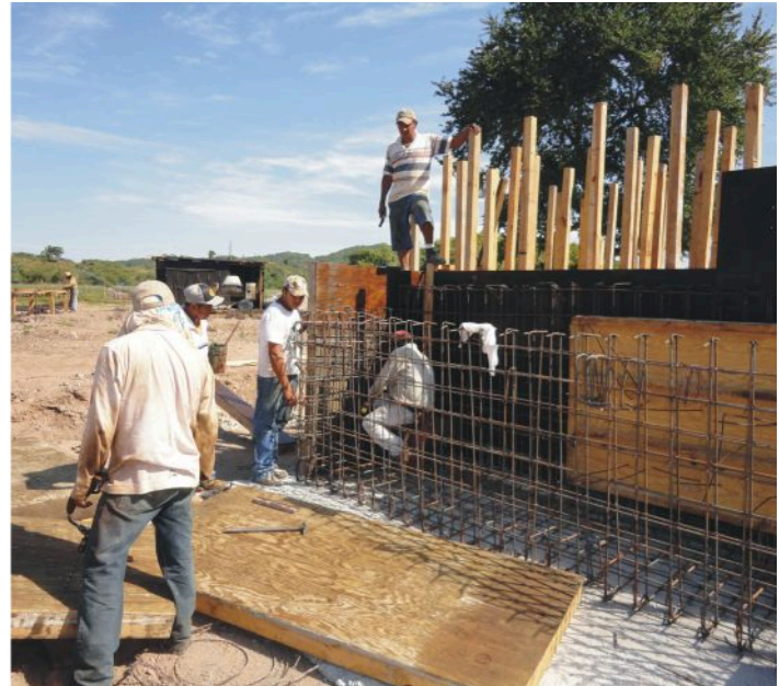
Se lleva a cabo la rehabilitación de la planta de tratamiento de Nuevo Vallarta.
