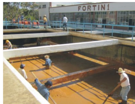
El organismo operador de Oaxaca restablece la estructura hidráulica de la planta potabilizadora Fortín 1.
