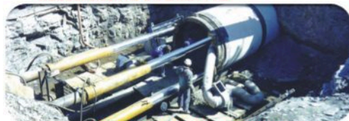
TUBO HINCA (MICROTUNELEO)
