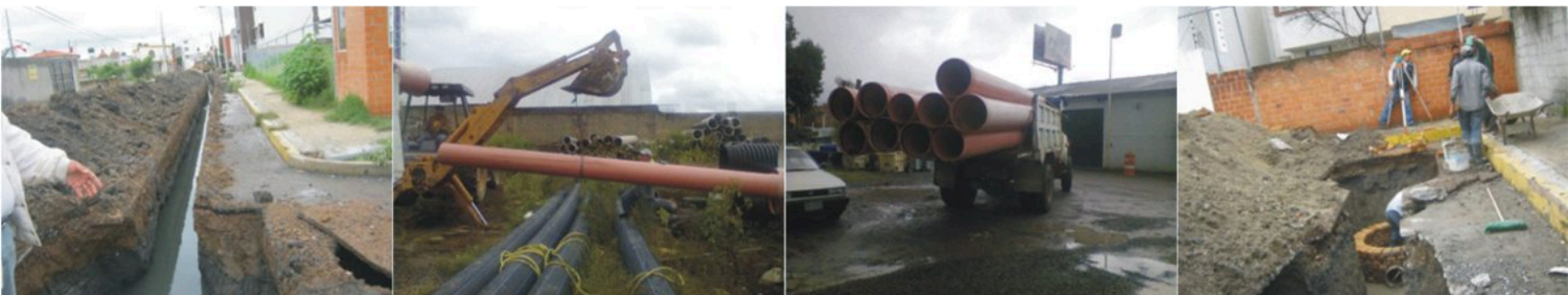
Puebla realiza obras de drenaje.
