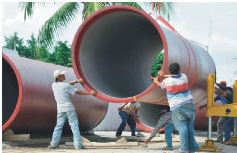
Tercera etapa del colector.
