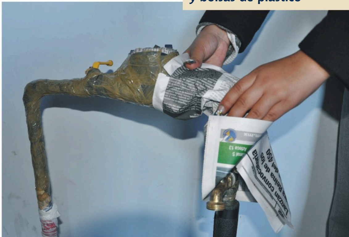
Protegen tuberías por el invierno.
