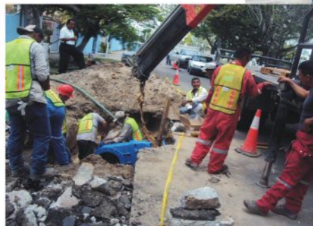
Instalación de válvula de 18 pulgadas.
