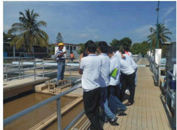
Estudiantes en visita guiada a la planta potabilizadora Cayaco.
