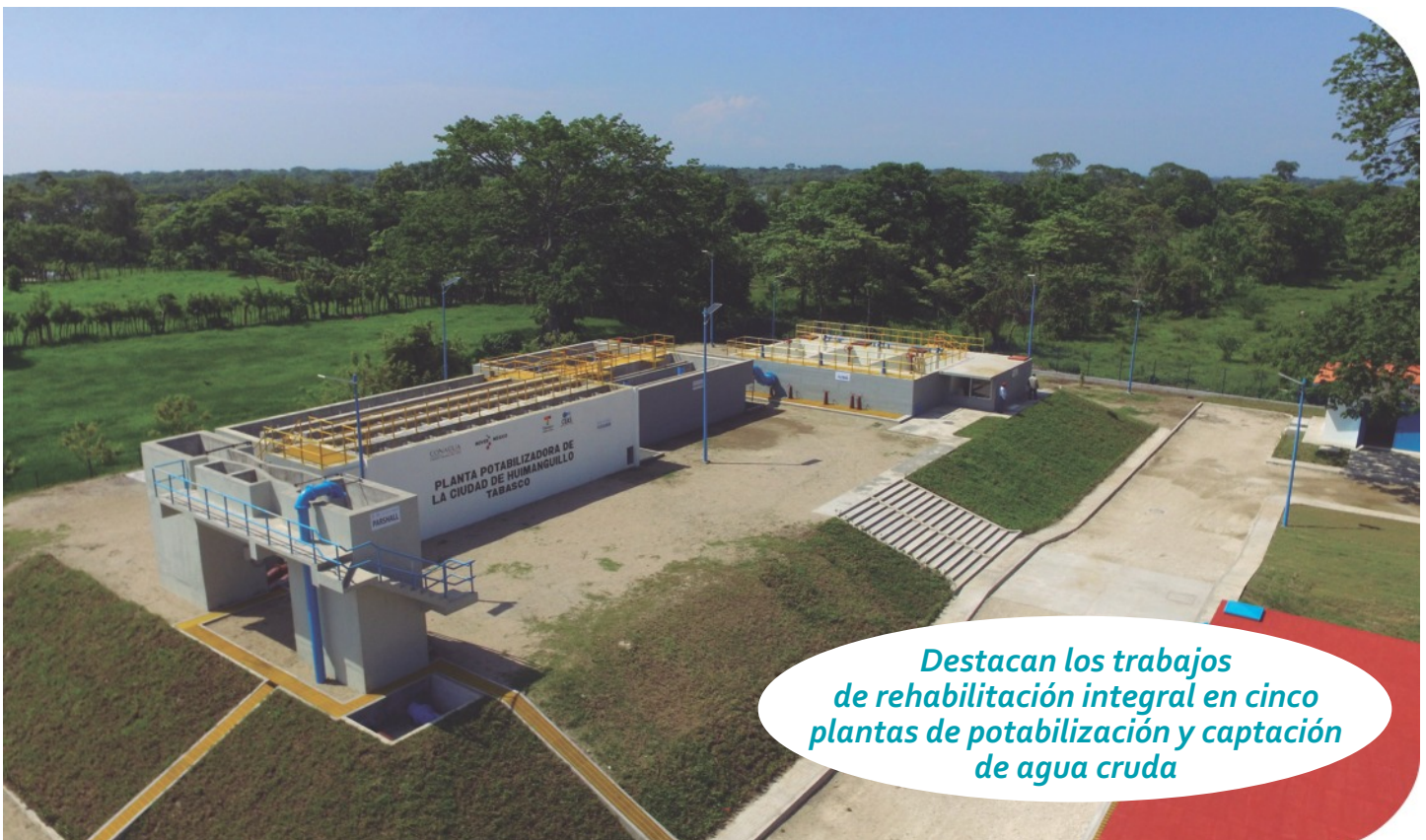
Planta Potabilizadora Huimanguillo.
