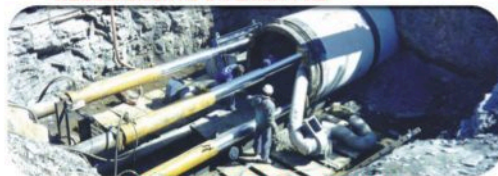
TUBO HINCA (MICROTUNELEO)
