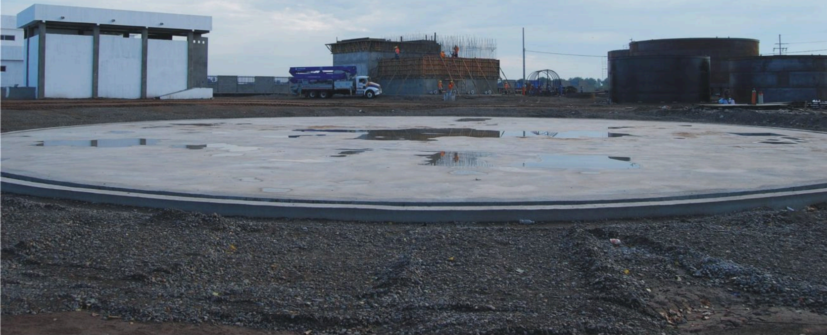
Planta potabilizadora de 500 litros.
