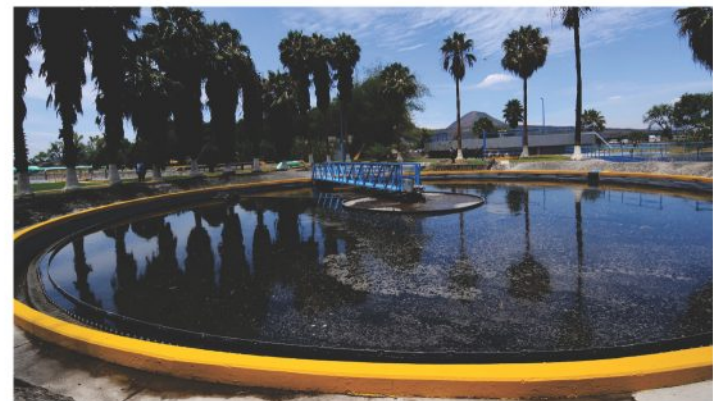
Planta de tratamiento de aguas residuales.
