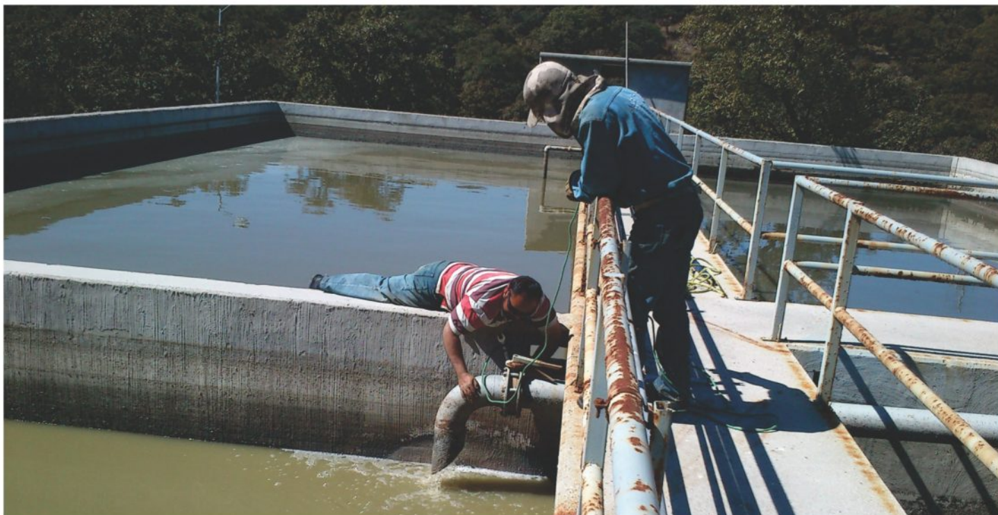
Rehabilitación de la planta de tratamiento Galaxia La Calera.
