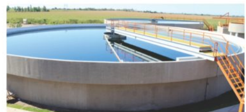
Planta tratadora de aguas residuales Culiacán Sur.
