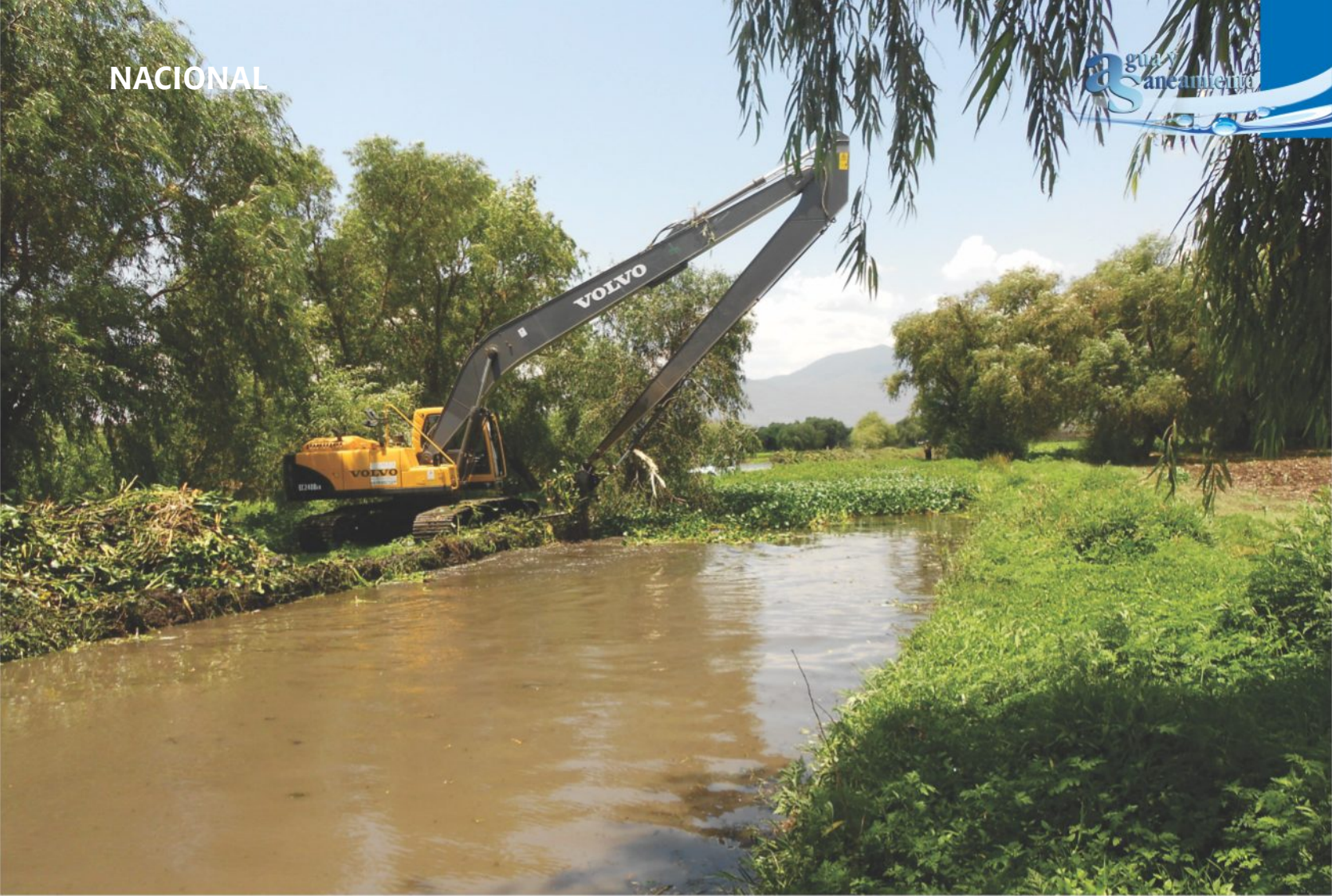
Limpieza en drenes.
