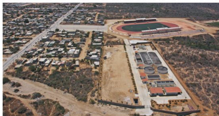
Planta de tratamiento de aguas residuales Los Cangrejos.
