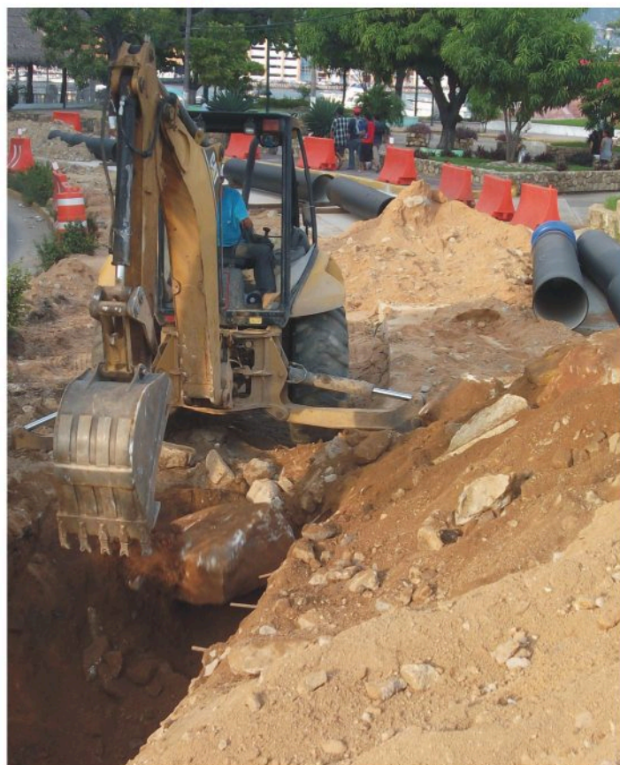
Obras para el abastecimiento de agua en Chilpancingo.
