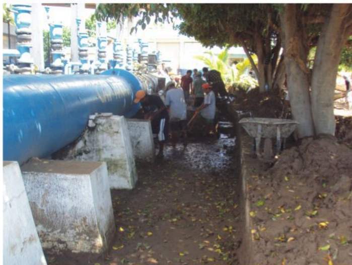
Limpieza y retiro de lodo.
