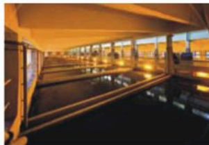
Un sistema diseñado inteligentemente, usa sopladores rotatorios para suministrar oxígeno constante a los reactores para que las bacterias puedan desarrollarse.
