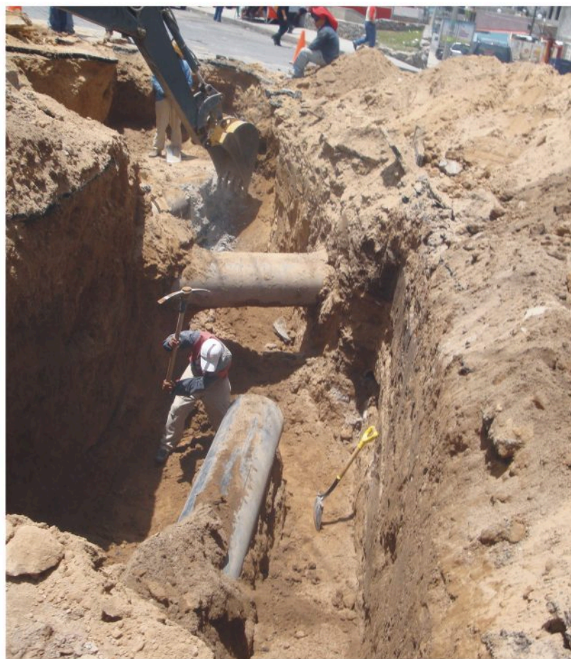
CAASIM realiza sustitución de línea de distribución.
