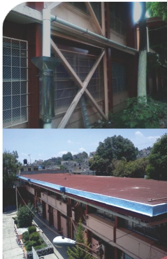
Secundaria Diurna No. 204, Hermilo Novelo. • Captación en techos. • Superficie de 520 m 2 . • Volumen cosechado en 2012: 220 m 3 = 22 pipas.
