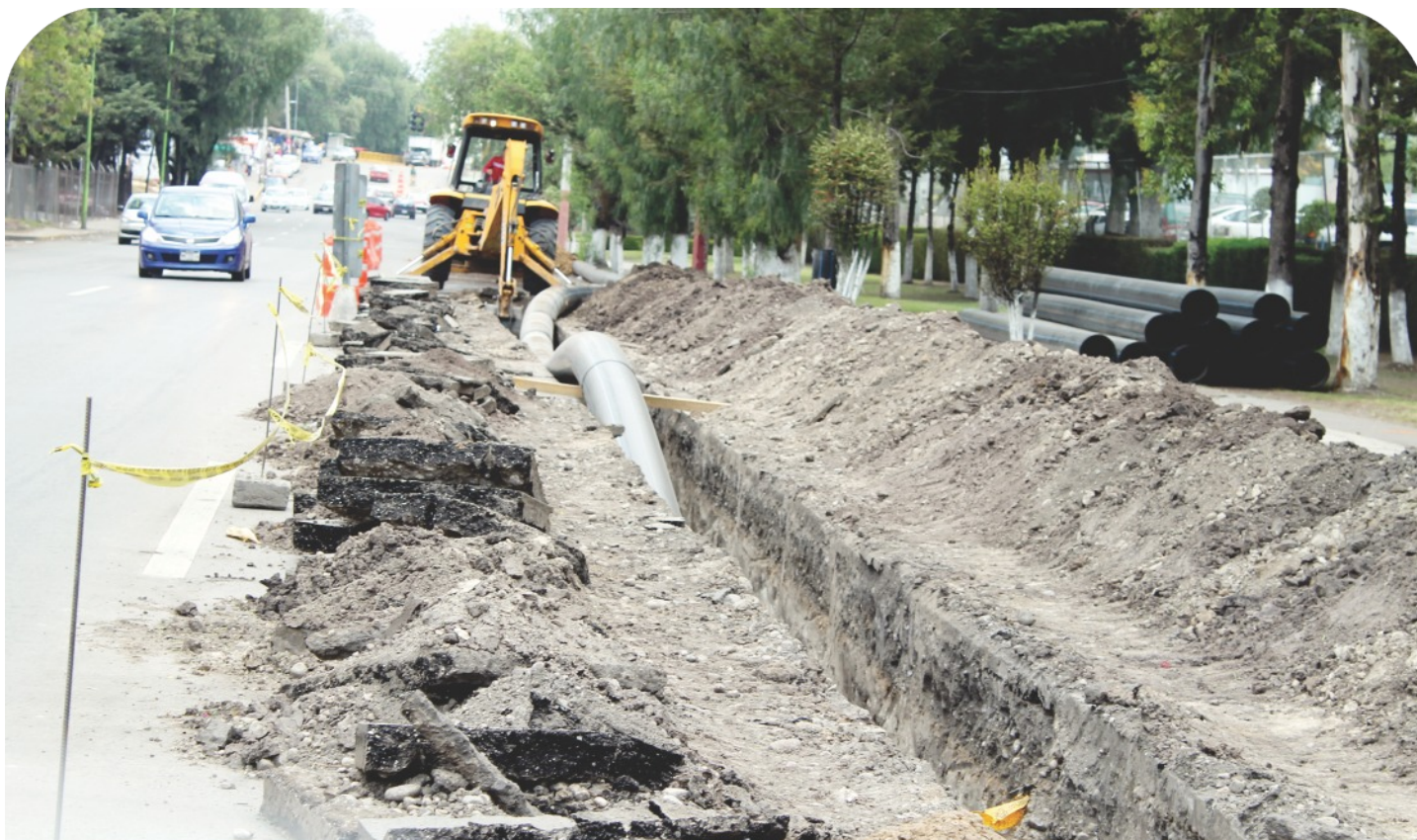
Introducción de tubería en el municipio de Izcalli.
