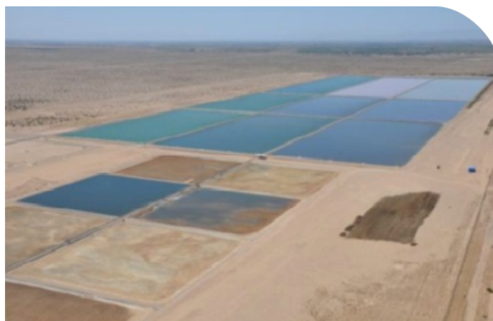
Planta de tratamiento y lagunas de infiltración.
