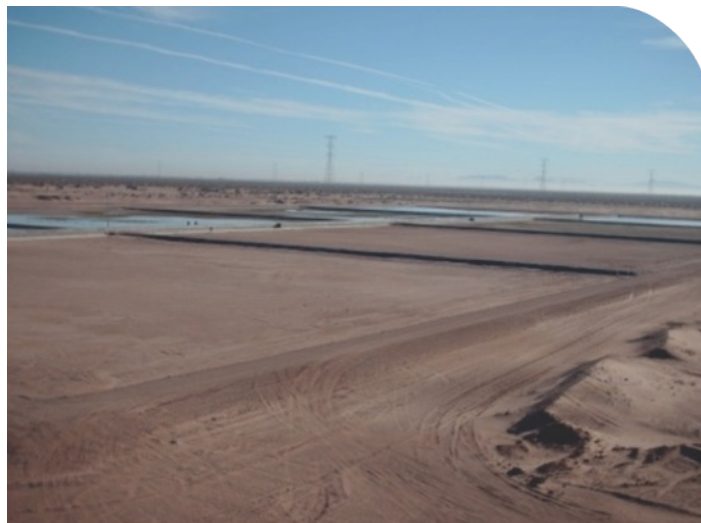
Inicio del vertido de aguas tratadas para infiltración.
