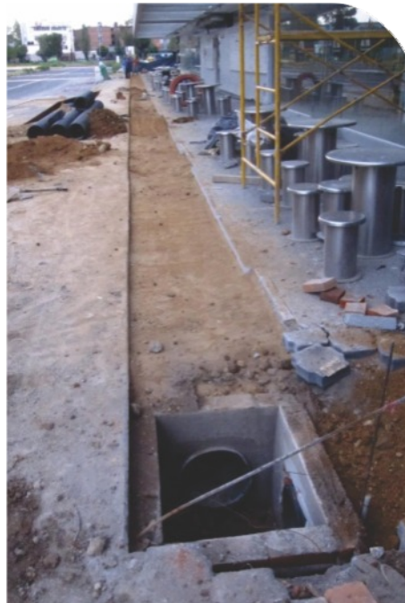
Implementación de la red pluvial para aprovechamiento en nuevos edificios UAM-I.
