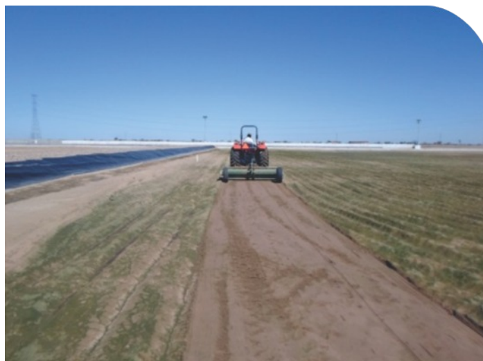
Sedimento de materia orgánica en las lagunas de infiltración y rastrado para retirar sedimentos de materia orgánica y recuperar la capacidad de infiltración de las lagunas.
