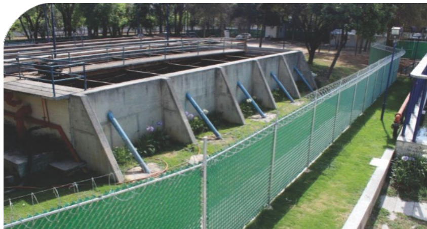
Planta de tratamiento Chapultepec.
