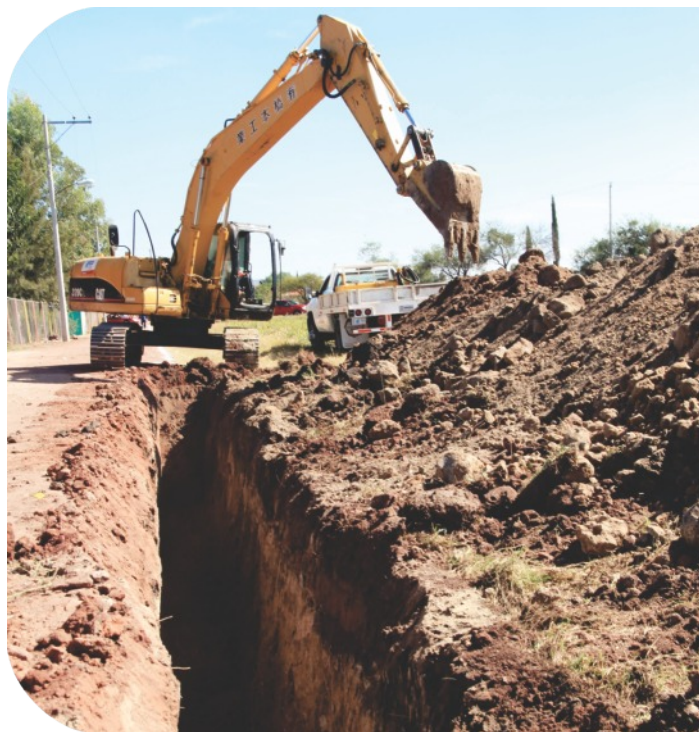
La CEA destinó durante 2015 una inversión por más de 179.1 millones de pesos, mediante la ejecución de 44 obras y acciones de drenaje.
