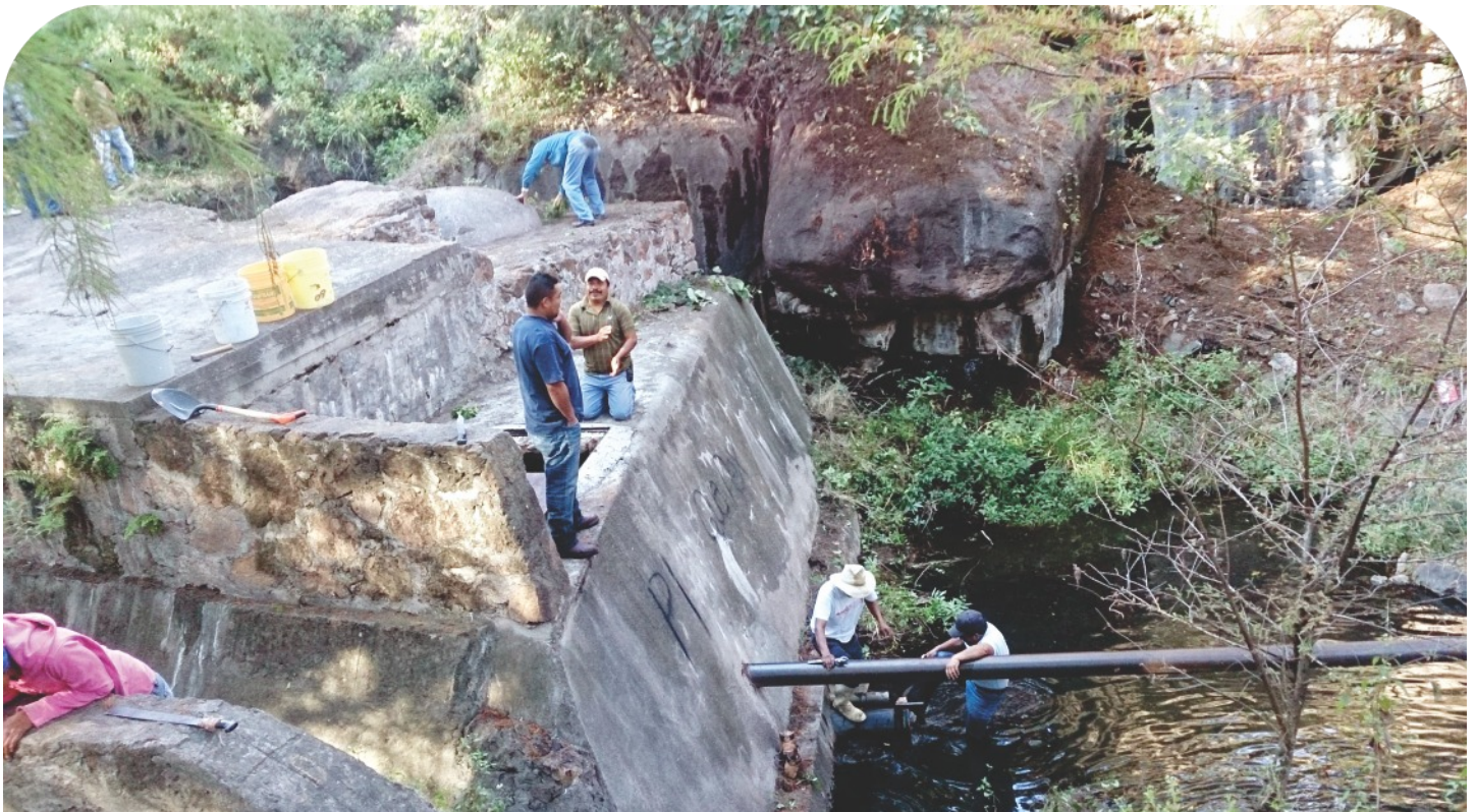
Habitantes de la comunidad de Bothe, Hidalgo, realizando trabajos a su infraestructura hidráulica.
