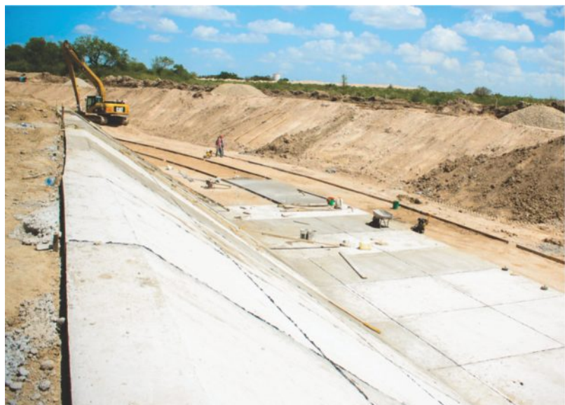
Obras de infraestructura.
