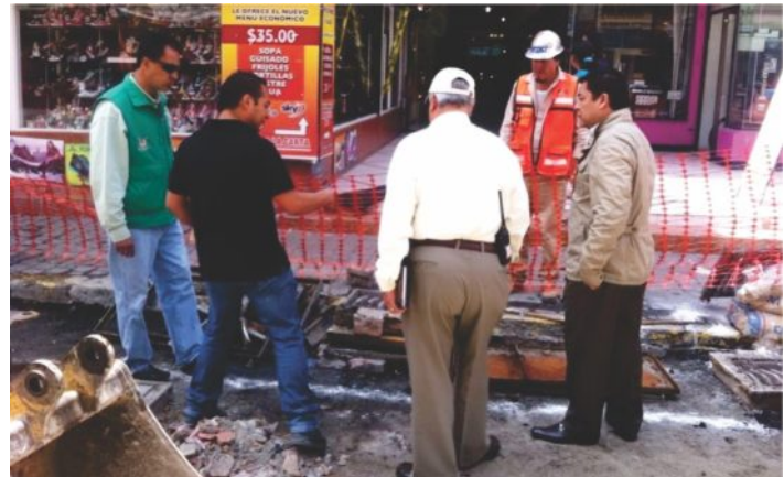
Obras de rehabilitación en Pachuca.
