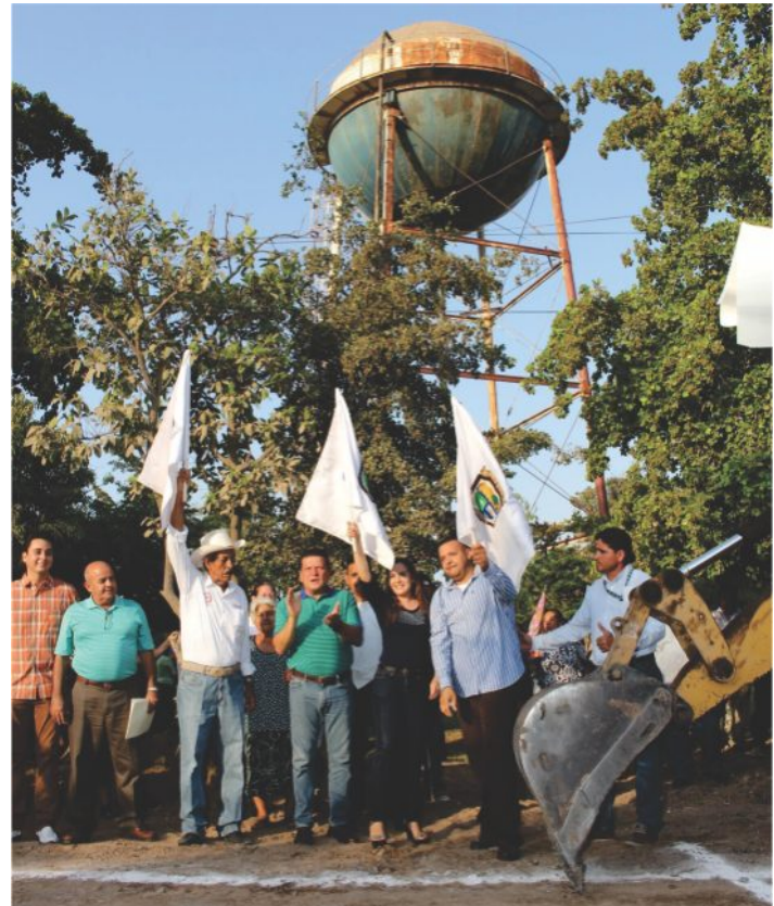
Presidente Municipal de Guasave da el banderazo de arranque de las obras.
