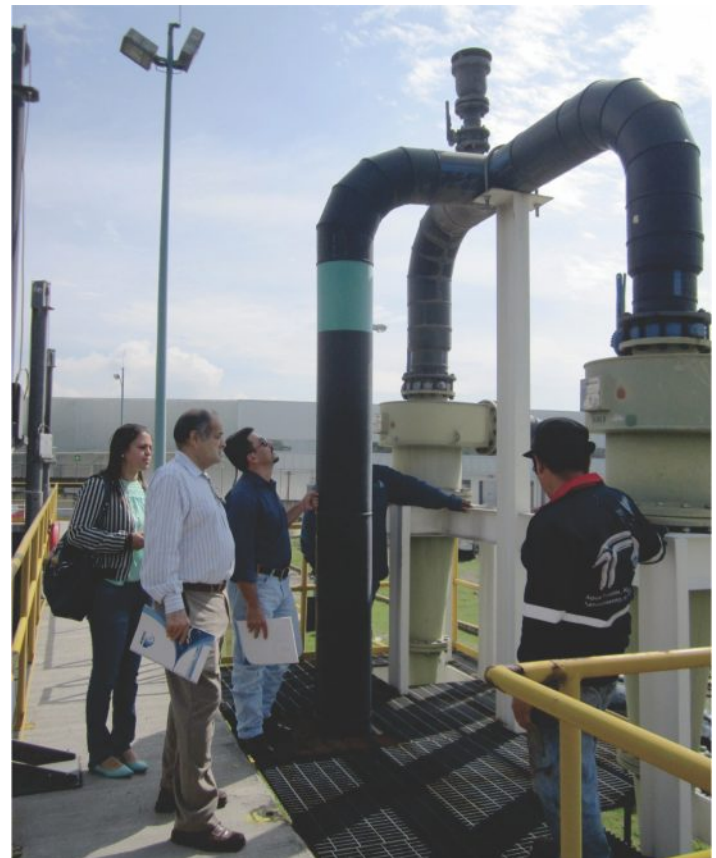
AHPSAS en visita a pozo del OPDAPAS , Metepec, Estado de México.
