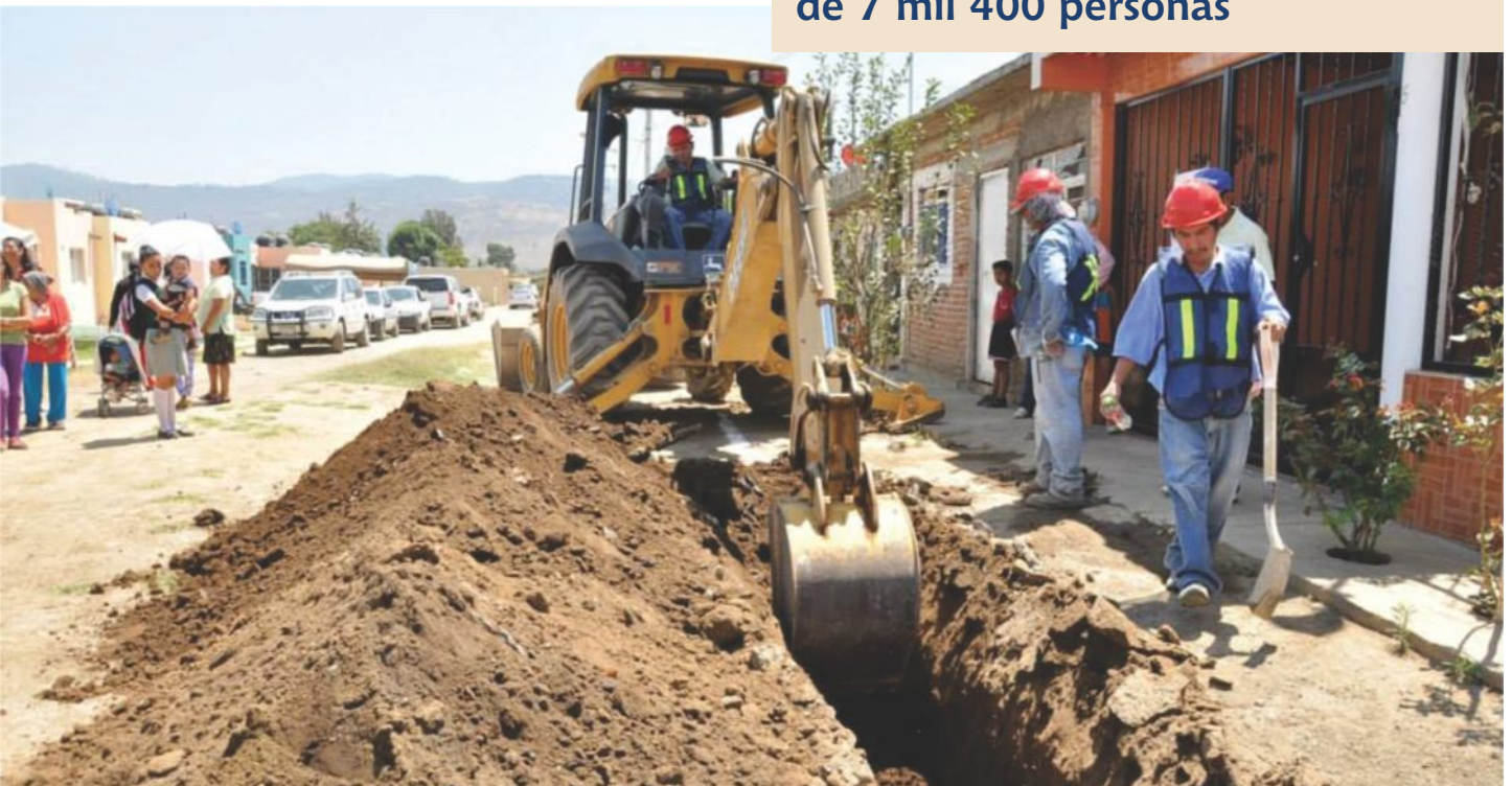
Obras del programa Primero Agua.
