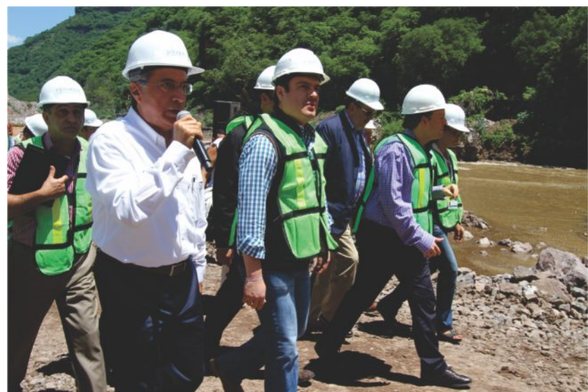
Supervisión de obra el Purgatorio.
