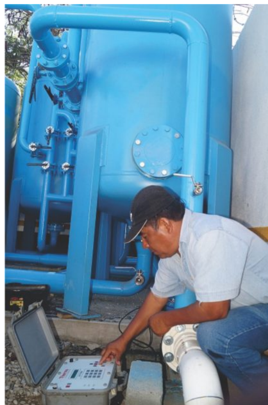
Se ha rehabilitado al 100% la planta clarificadora San Felipe del Agua.
