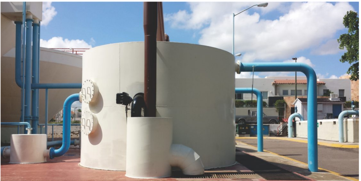
Propuesta de mejora en la etapa de filtración en planta potabilizadora con diseño de lodos activados.
