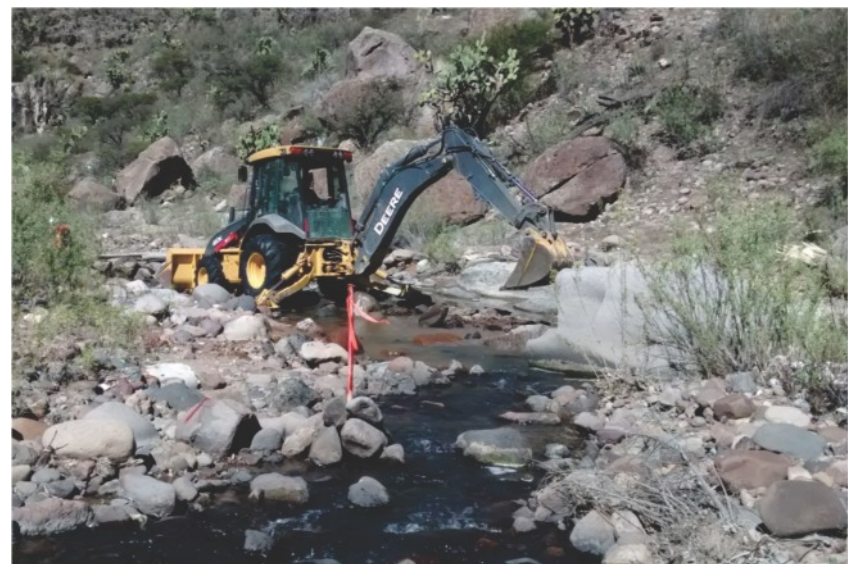
La obra hidráulica más grande para el estado de Zacatecas.
