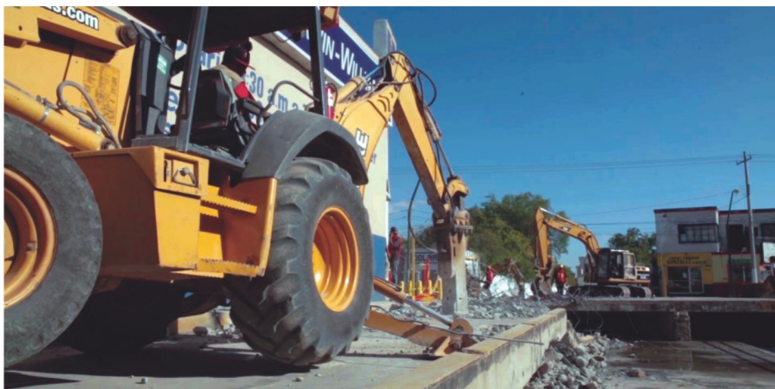
Obras para prevenir inundaciones en Piedras Negras, Coahuila.
