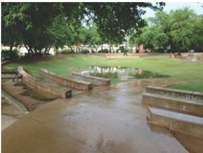
El sistema de retención de agua de la infraestructura verde permite que el agua de las tormentas se acumule y se infiltre lentamente a los acuíferos.
