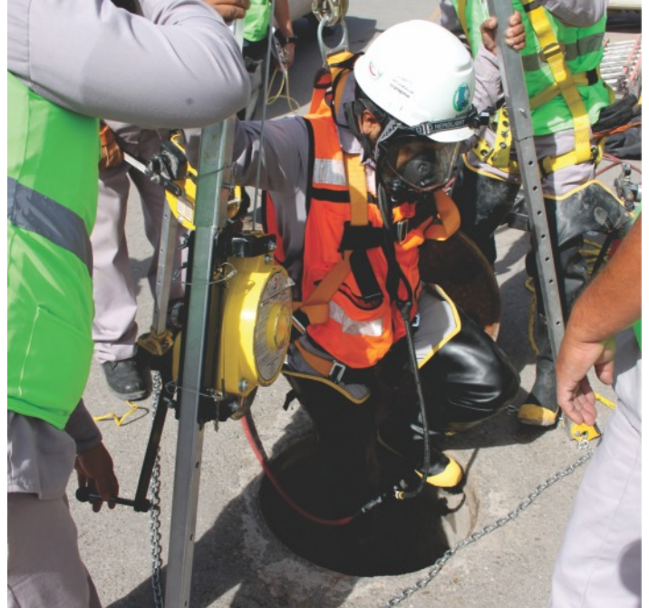
Realización del ejercicio-simulacro en alcantarilla con una profundidad de 2.50 metros.
