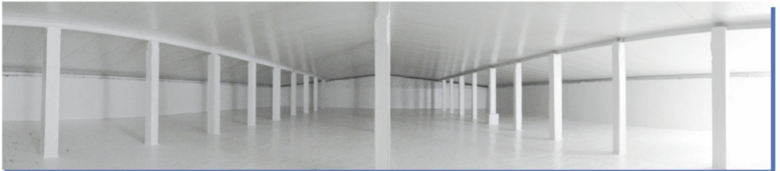
Tanques de concreto, mampostería y metálicos
