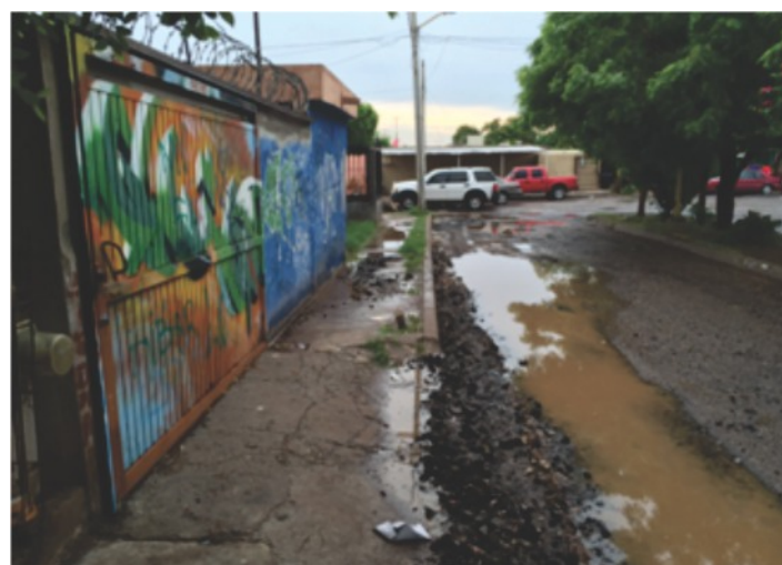
La ciudad de Hermosillo no cuenta con drenaje pluvial, por lo tanto las calles se inundan durante las lluvias, provocando daños a las calles y a la infraestructura urbana. (Foto de Kacey Ernst)
