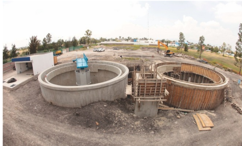
Construcción de plantas de tratamiento de aguas residuales en Guanajuato.
