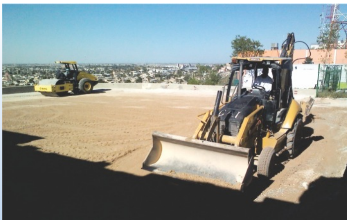
Construcción de tanque en la Laguna.
