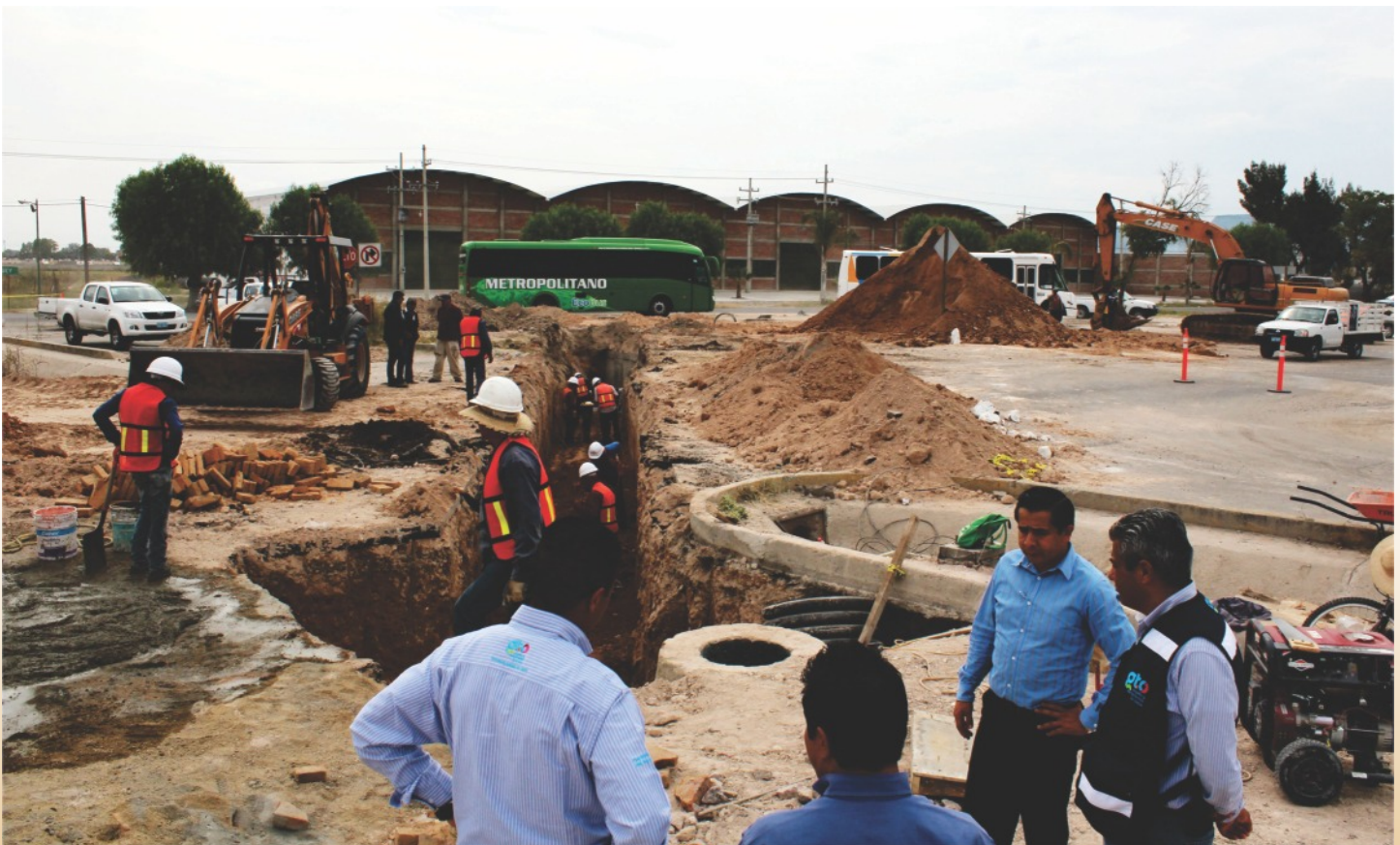
Obras del Colector Oriente en San Francisco del Rincón, Guanajuato.
