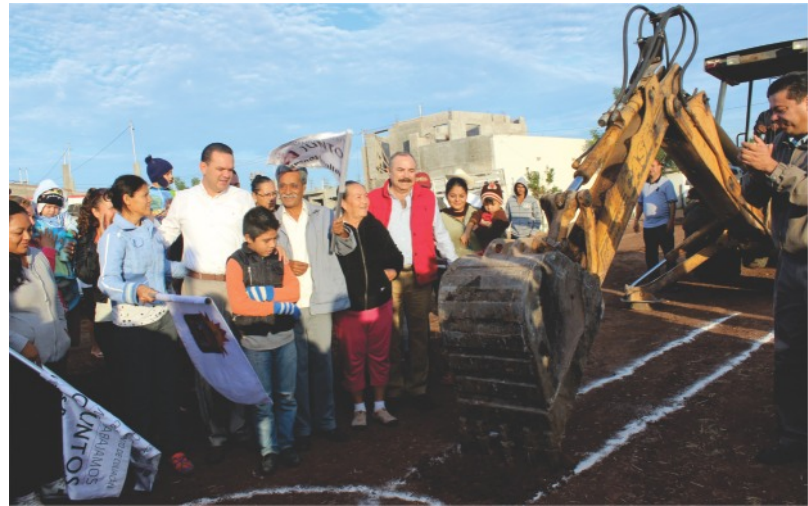
Banderazo de obras de alcantarillado sanitario.
