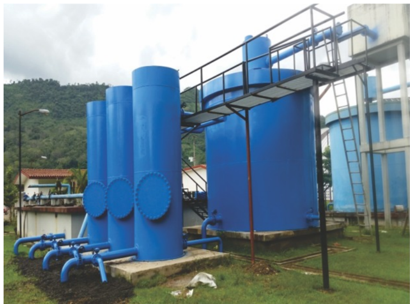
La obra se realizó con una inversión de 13 millones 468 mil 731 pesos, provenientes del Programa de Infraestructura Indígena.
