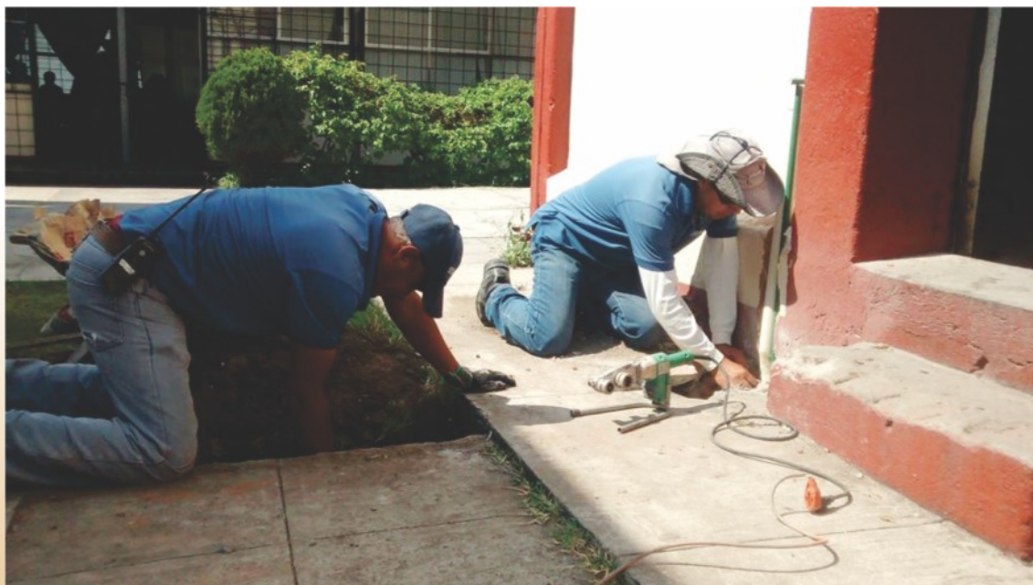
Programa de detección y reparación de fugas en escuelas de Atlixco, Puebla, con el fin de recuperar hasta un 20% de agua.
