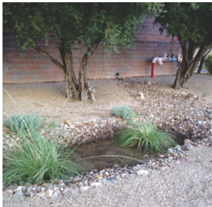
La infraestructura verde cerca de los edificios no solo hace que rindan los aparatos de refrigeración, sino que también se aprovecha la lluvia que cae en las azoteas, ya que se recolecta y se dirige a las áreas de infiltración.
