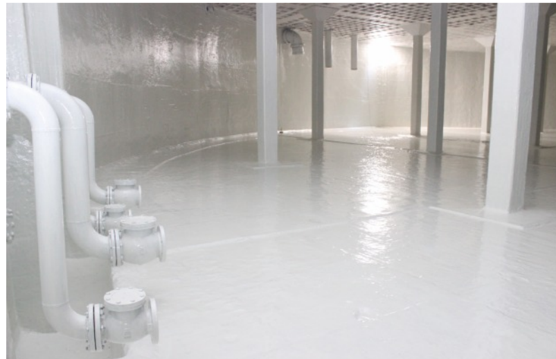
Interior del tanque de agua potable Diplomáticos, cambio de piezas especiales en líneas hidráulicas.
