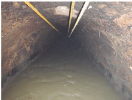
Colector 60"Ø desazolvado para su rehabilitación
