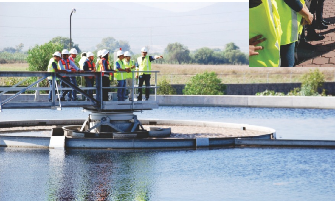
PTAR Norponiente en Celaya, Guanajuato.
