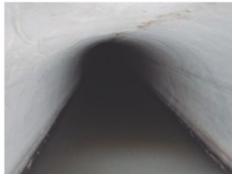
Colector 60"Ø Rehabilitado por método CIPP
