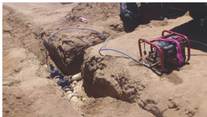
Instalación de red de distribución de agua potable.
