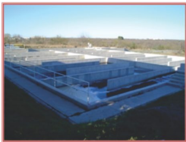
Estación de bombeo.
