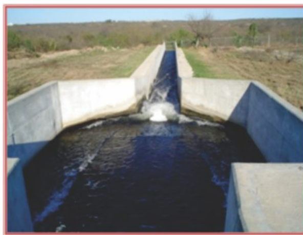
Zanjas de oxidación.
