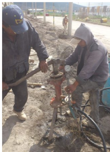
Instalación de toma domiciliaria de agua potable.
