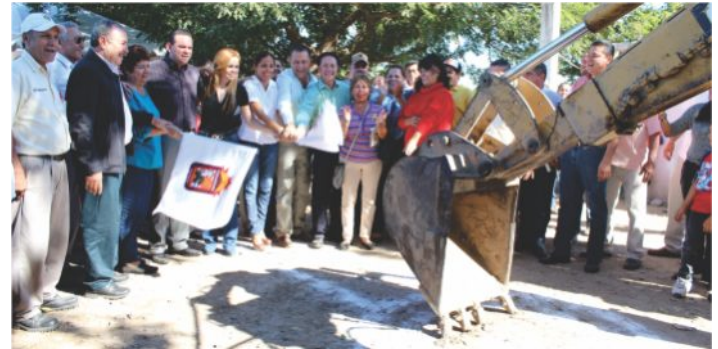
Realizan obras en Culiacán, Sinaloa.
