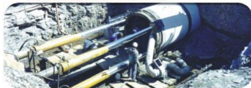
TUBO HINCA (MICROTUNELEO)
