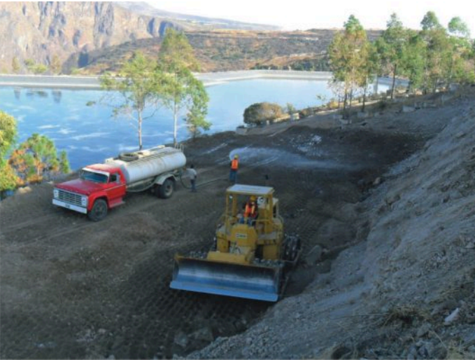
Construcción de camino de acceso a PTAR.
