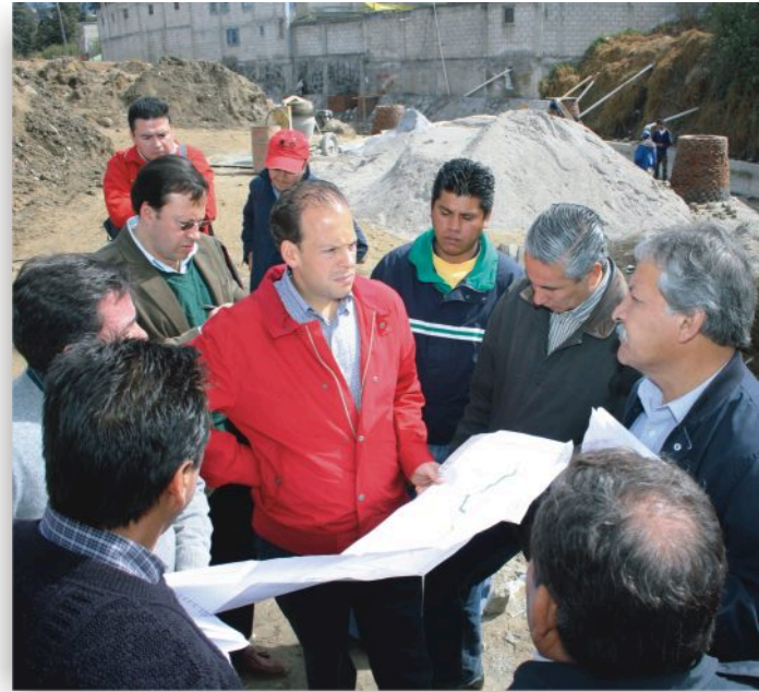
El Secretario David Korenfeld Federman supervisa el avance en la construcción del colector de aguas residuales y el canal para aguas pluviales que el Gobierno de Edomex realiza en Xalatlaco.
