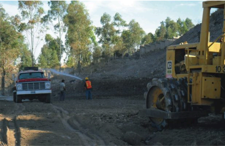
Construcción de camino de acceso a PTAR.
