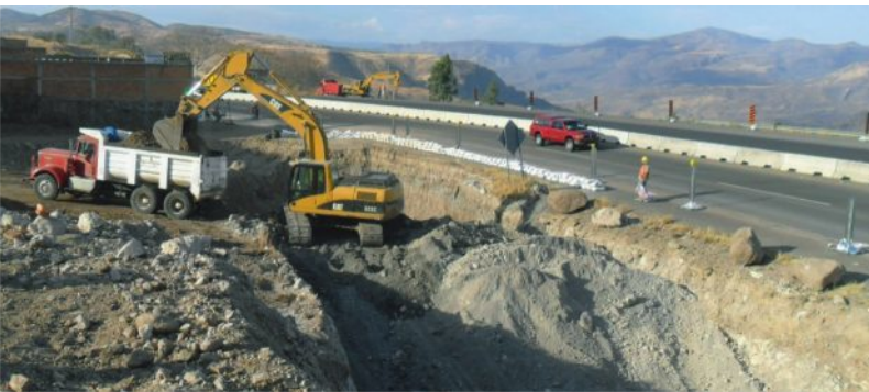
Salida de Paso Deprimido, proveniente de PTAR.
