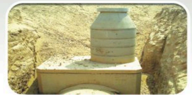
POZO DE VISITA
