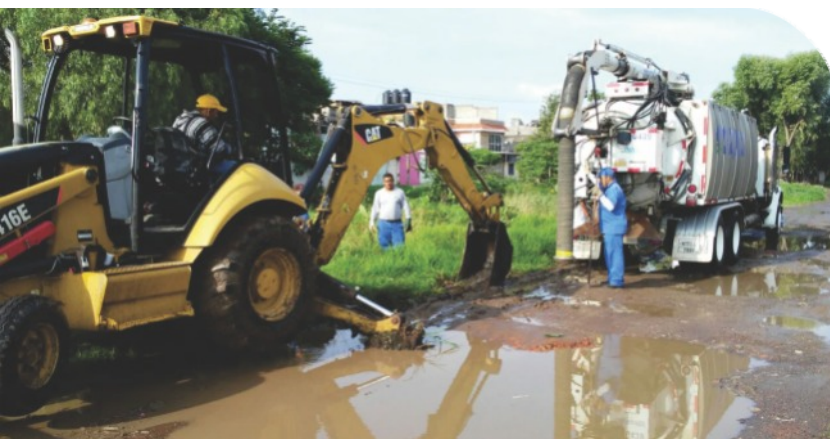
Completaron ocho jornadas de limpieza en cunetas, canales y drenes.
