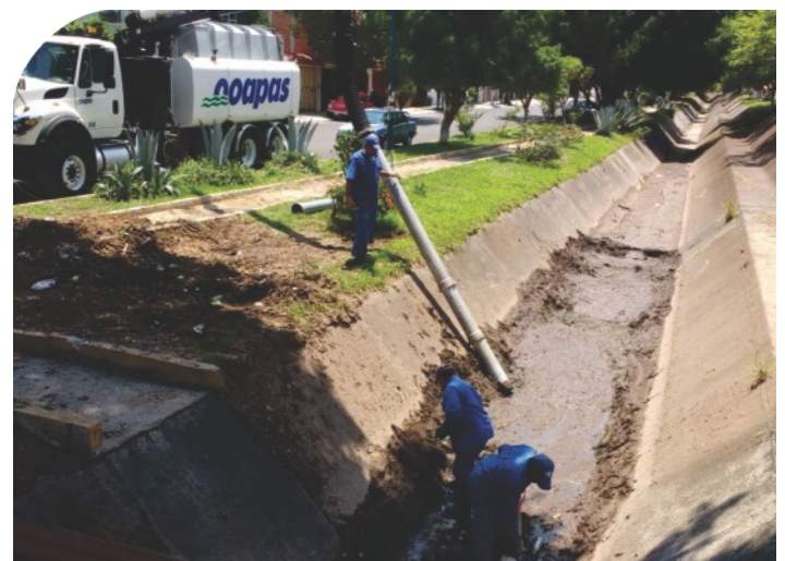
OOAPAS realiza limpieza y desazolve en 43 kilómetros de red sanitaria.
