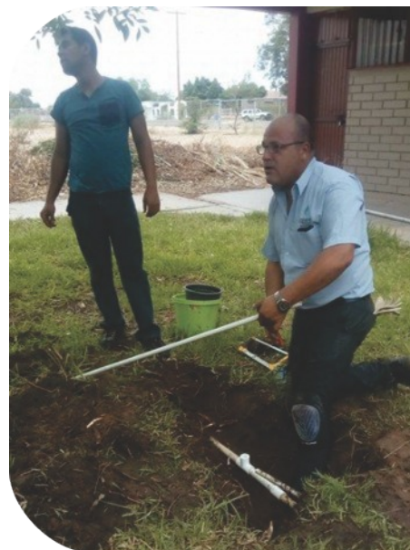
Personal de OOMAPAS muestra cómo se lleva a cabo la reparación de una fuga.
