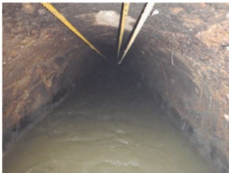
Colector 60"Ø desazolvado para su rehabilitación
