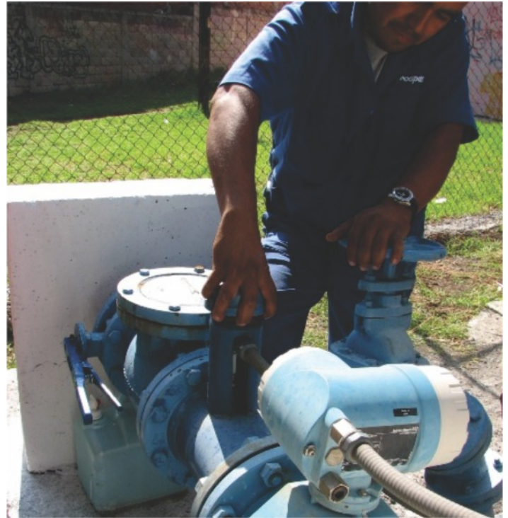
Obras de mantenimiento a pozo.
