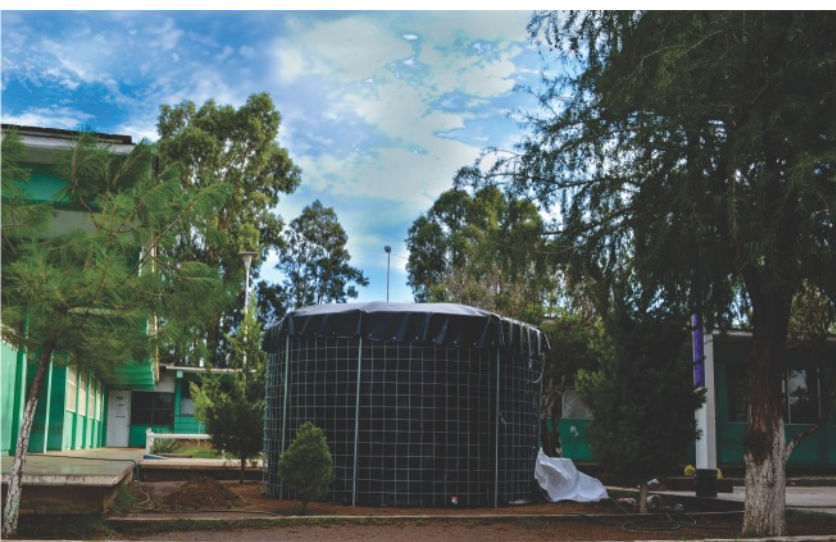
Tanque de captación.
