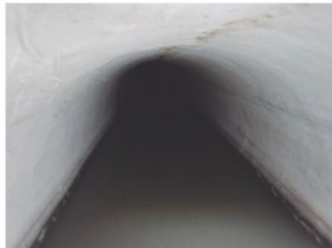
Colector 60"Ø Rehabilitado por método CIPP
