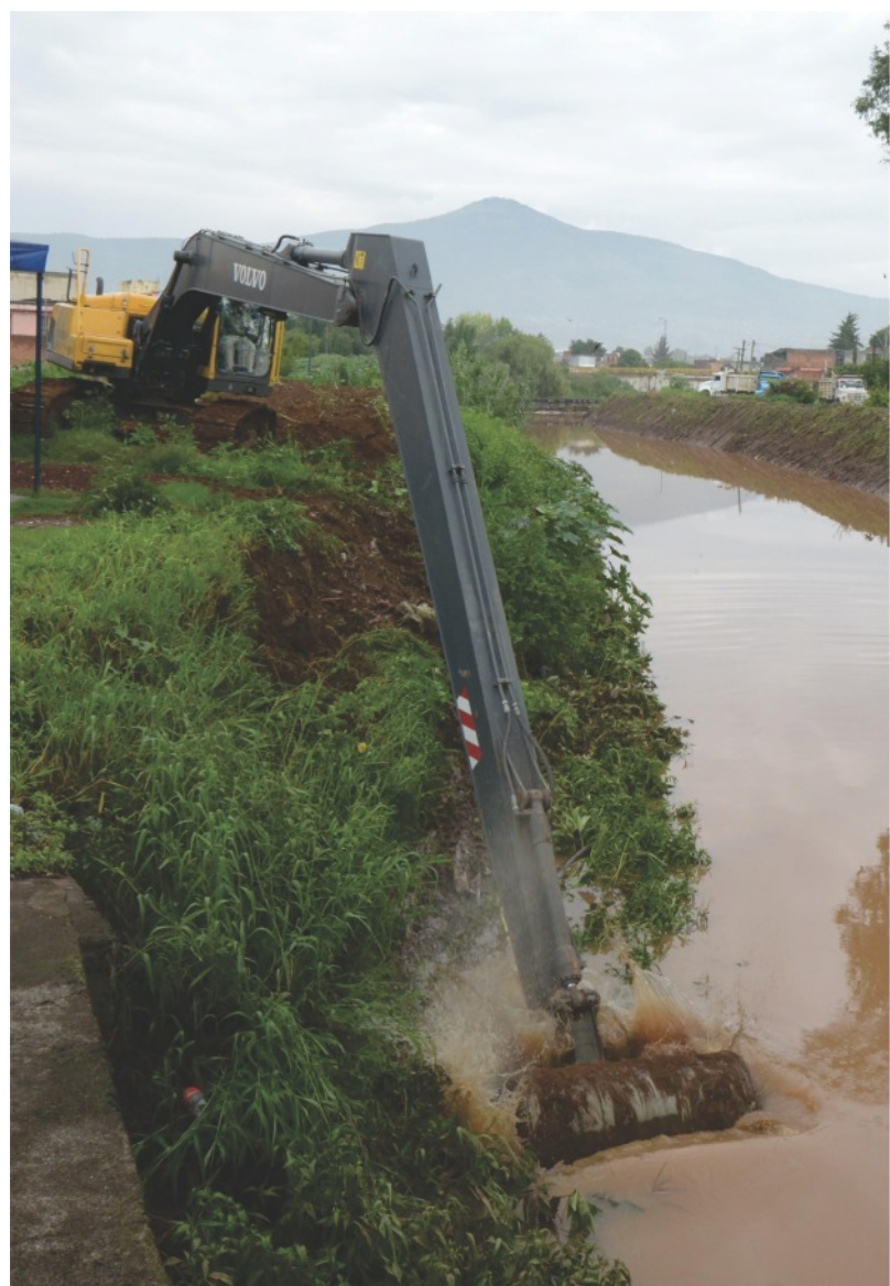
Obras de desazolve.
