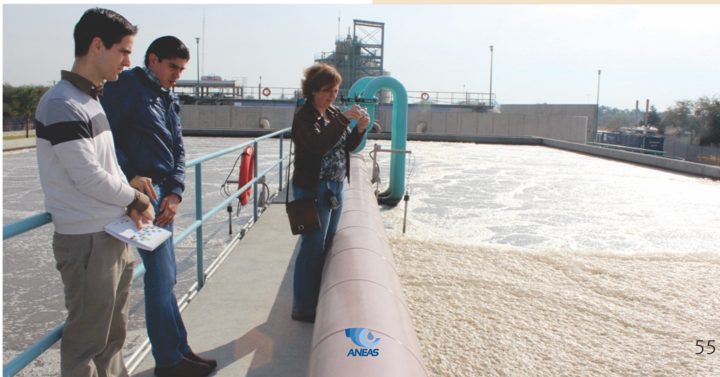
Planta de tratamiento del SAPAF .
