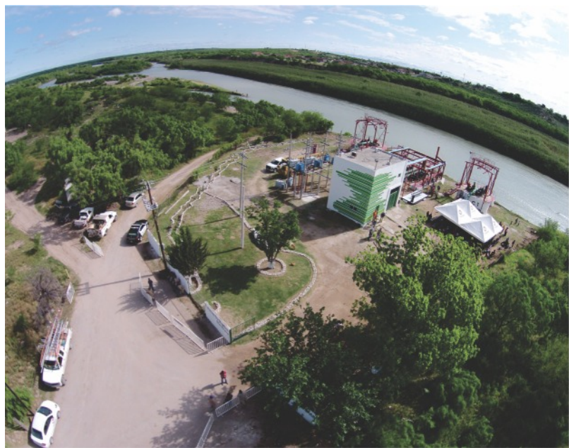
Vista aérea de la estación de bombeo del Río Bravo.
