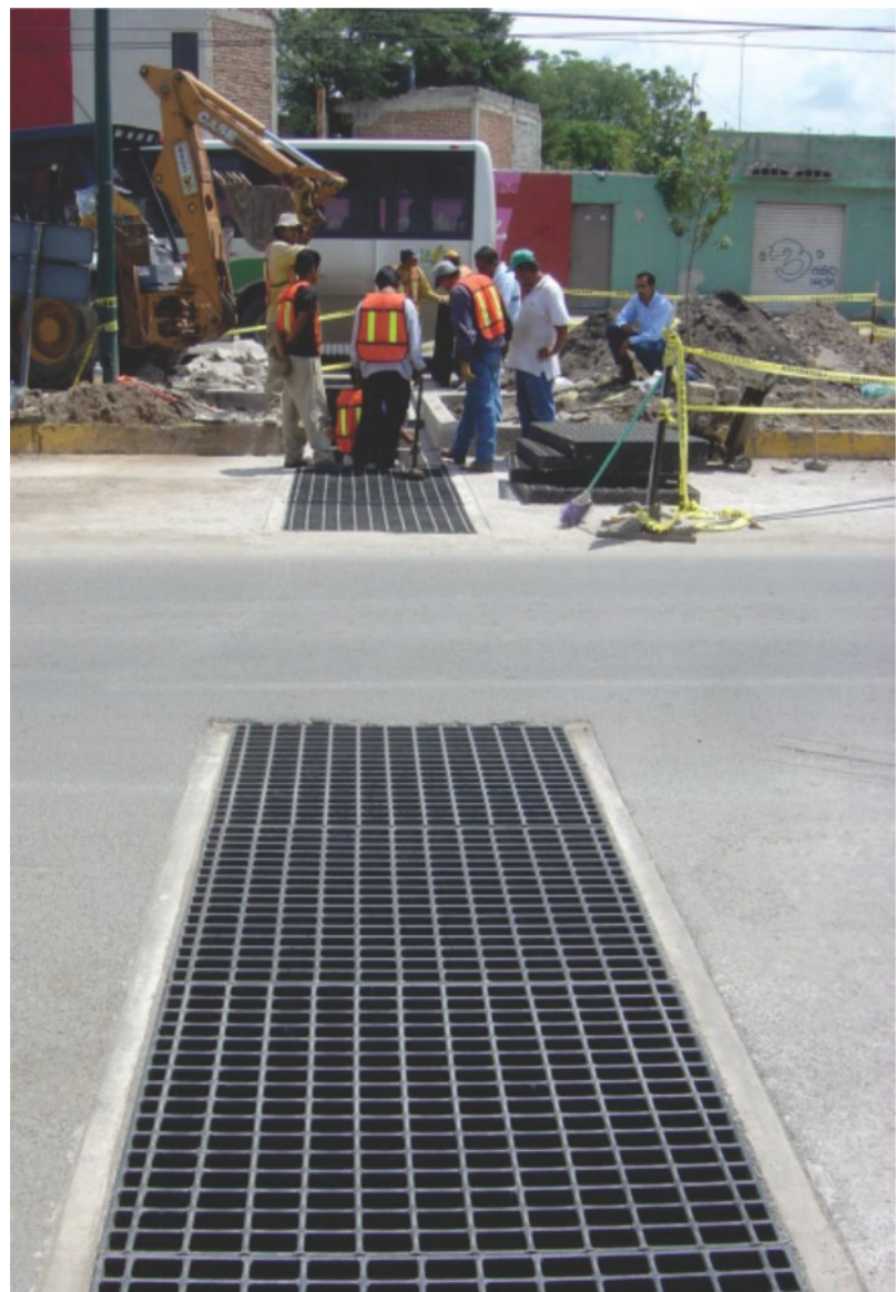
Obras en León para prevenir encharcamientos.
