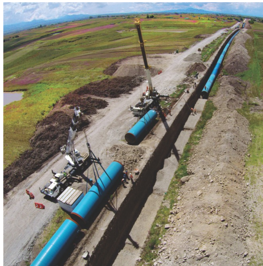
Preparación de izaje de tubería para colocación de zanja.
