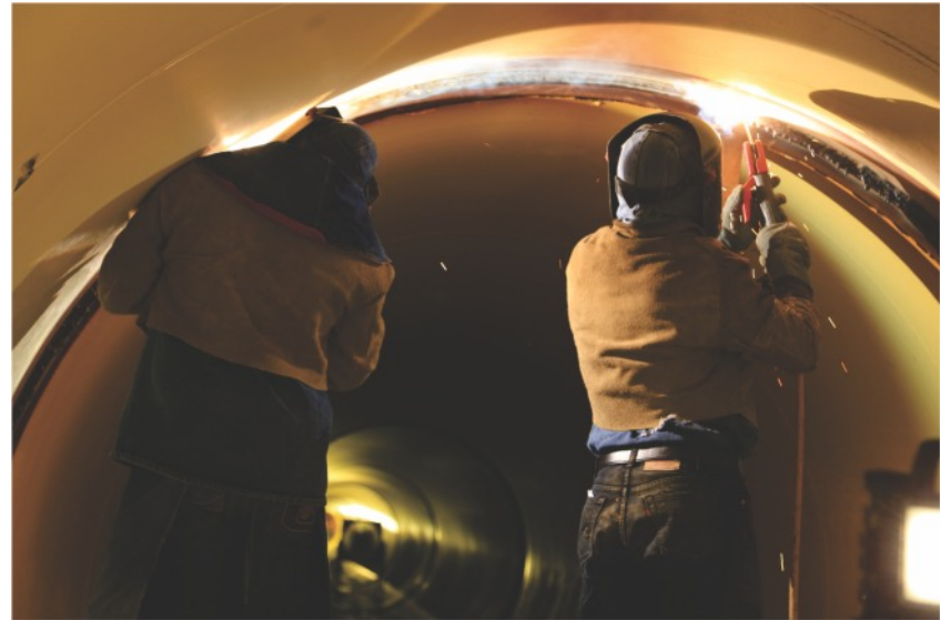
Aplicación de soldadura en frente Xonacatlán.
