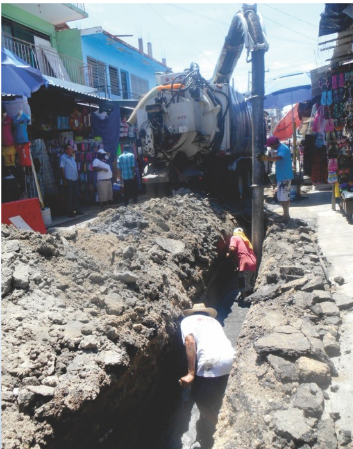
Rehabilitación de 45 metros lineales de tubería.
