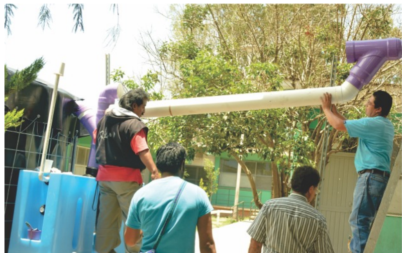
Armado de tubería para captación.
