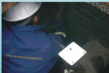
Imagen 3. Instalación de medidores electromagnéticos.
