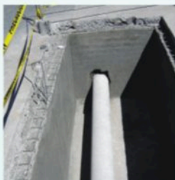
Imagen 2. Construcción de las estaciones de medición.
