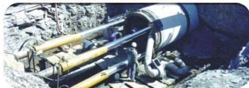
TUBO HINCA (MICROTUNELEO)
