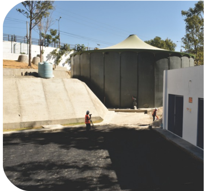
Esta planta tendrá una capacidad total de 270 litros por segundo.
