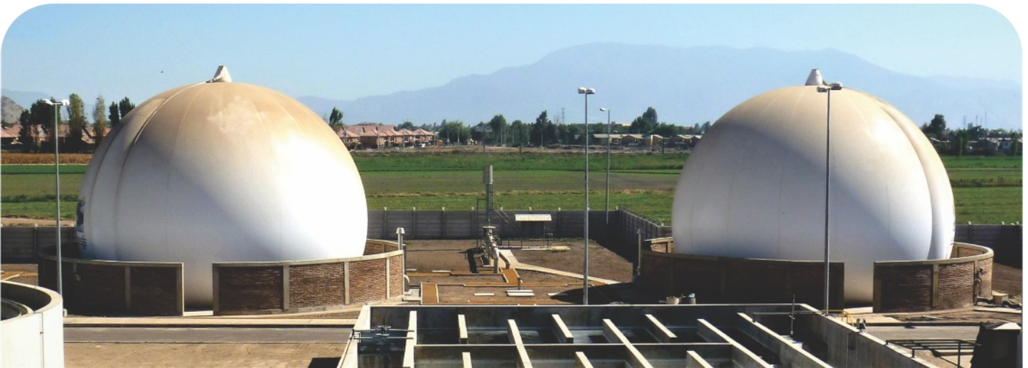
Figura 2. Gasómetros del sistema de biogás en la PTAR CCU Chile (cortesía IBTech).
