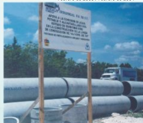
Línea doble Cancún, Q. Roo. Tubería clase B-9 de 450 mm de diámetro para flujo de agua tratada y de 500 mm para alcantarillado sanitario. Agosto 2003 / Abril de 2004
