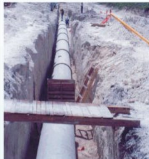
Instalación de línea de agua potable Cd. De Chetuma, Q. Roo Febrero de 2003 / Febrero de 2004
