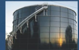
Proceso de 3 capas de revestimiento 1 fusión, ÚNICO EN EL MERCADO que ofrece una capa adicional de Dióxido de Titanio (TiO2) incrementando el espesor de revestimiento a 18 mils e incrementando la vida útil a más de 50 años
