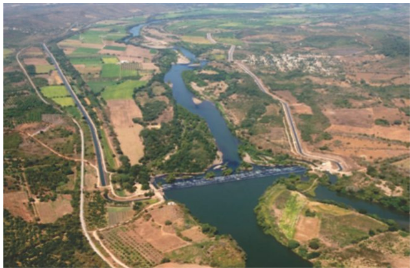
Vista aérea del Canal Centenario.
