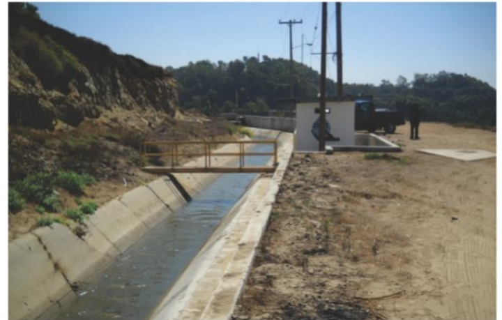
Canal de alejamiento hacia San Antonio de los Buenos.
