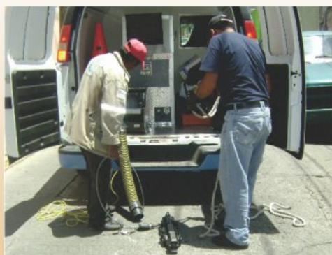
Equipo de video inspección de la red de alcantarillado sanitario.
