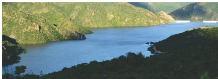
Presa El Realito.
