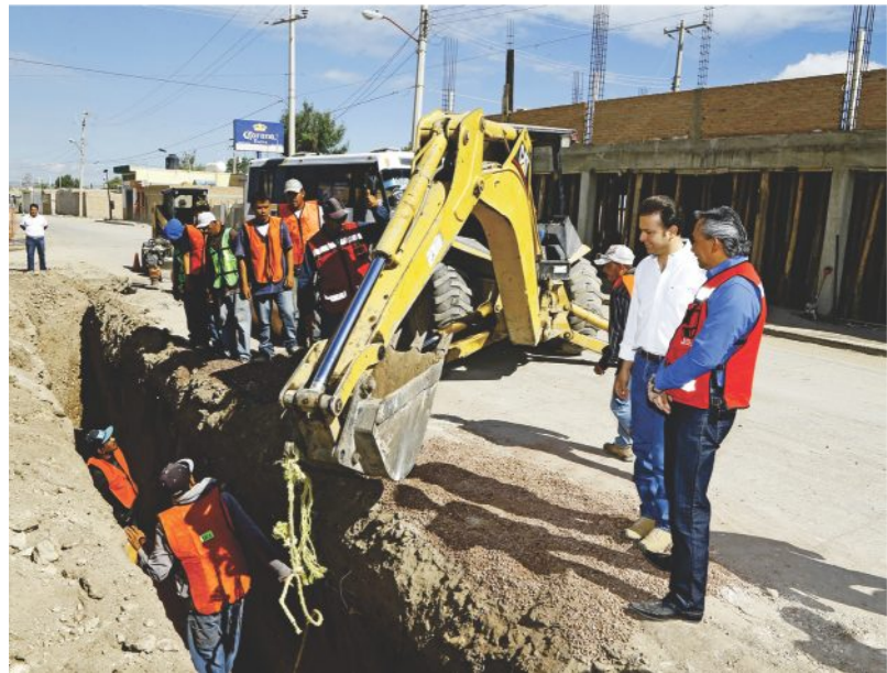
Obras de infraestructura hidráulica en Durango.
