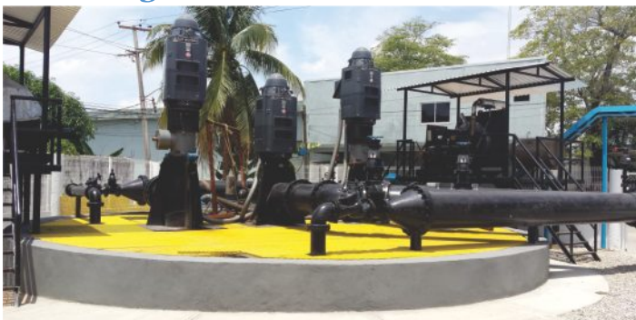
Renovación de infraestructura hidráulica en Tabasco.
