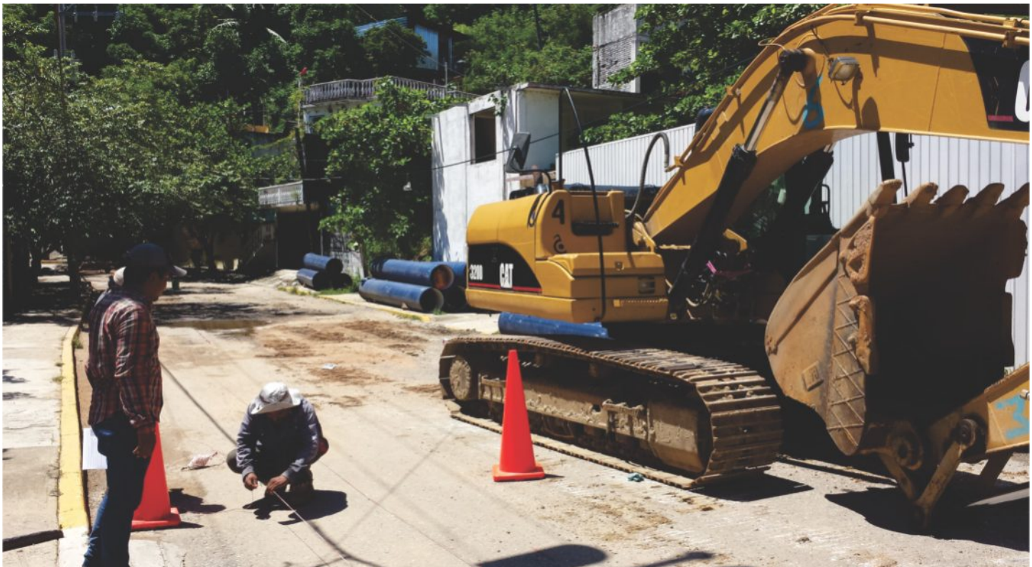
Sustitución de tubería en Acapulco.
