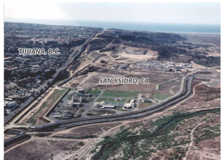
Planta Internacional de tratamiento de aguas residuales de Tijuana – San Diego.
