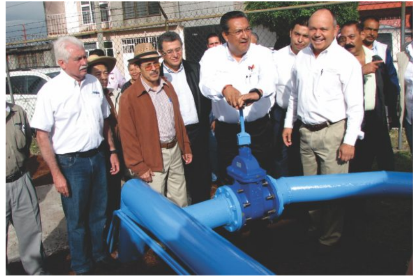
Ampliación del Acuaférico, en el tramo de la colonia Lago I a Av. Morelos Norte.
