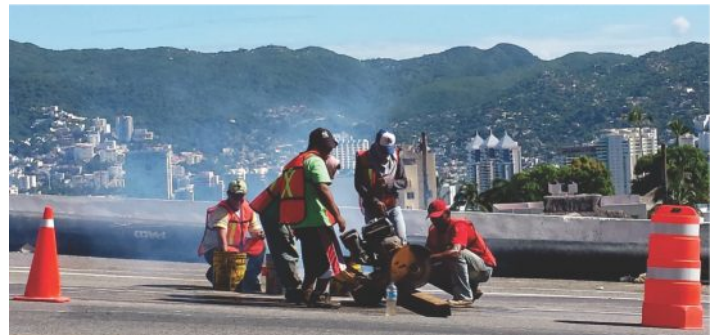
Sustitución de línea de conducción.
