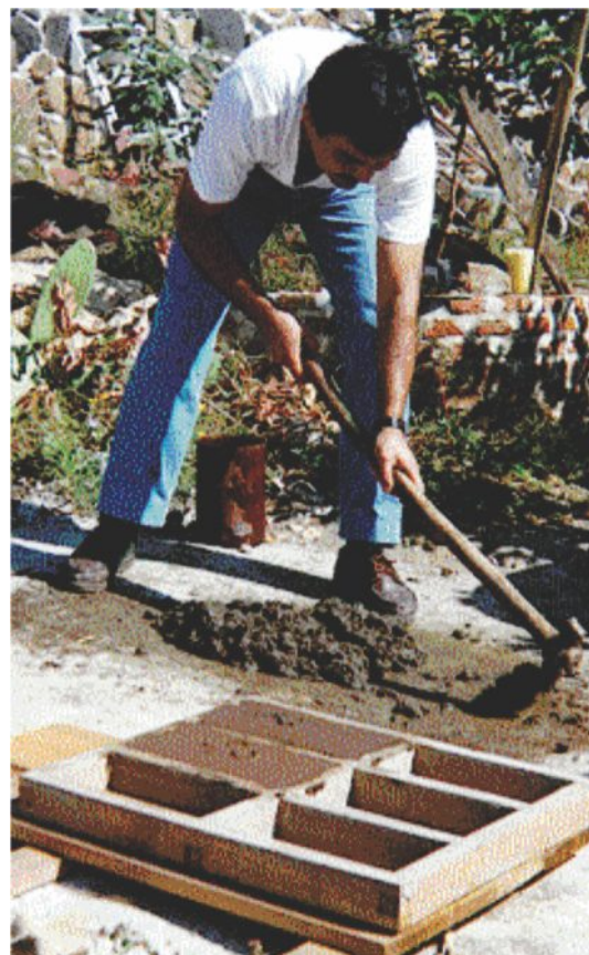
Moldeo de tabique.
