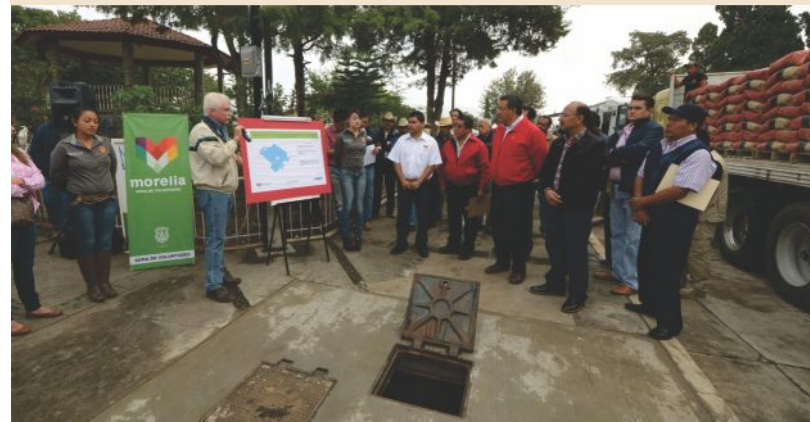
Rehabilitación de línea de conducción de agua en la Tenencia de San Nicolás Obispo.
