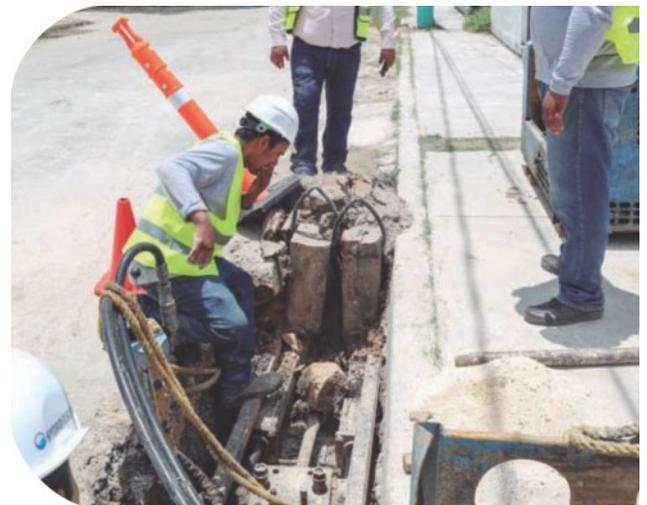
Rehabilitación de red de distribución de agua potable en Chetumal con el método denominado "Pipe Bursting" o reventamiento de tuberías.
