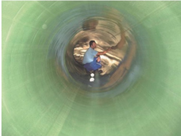
Tubería con refuerzo de fibra de vidrio y curado por UV para sistemas de agua potable de 8" a 60" Ø
