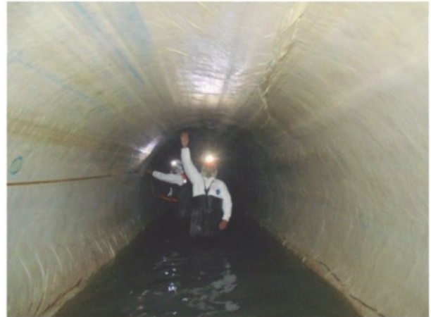
Tubería Curada en Sitio para sistemas de alcantarillado de 8" a 96" Ø
