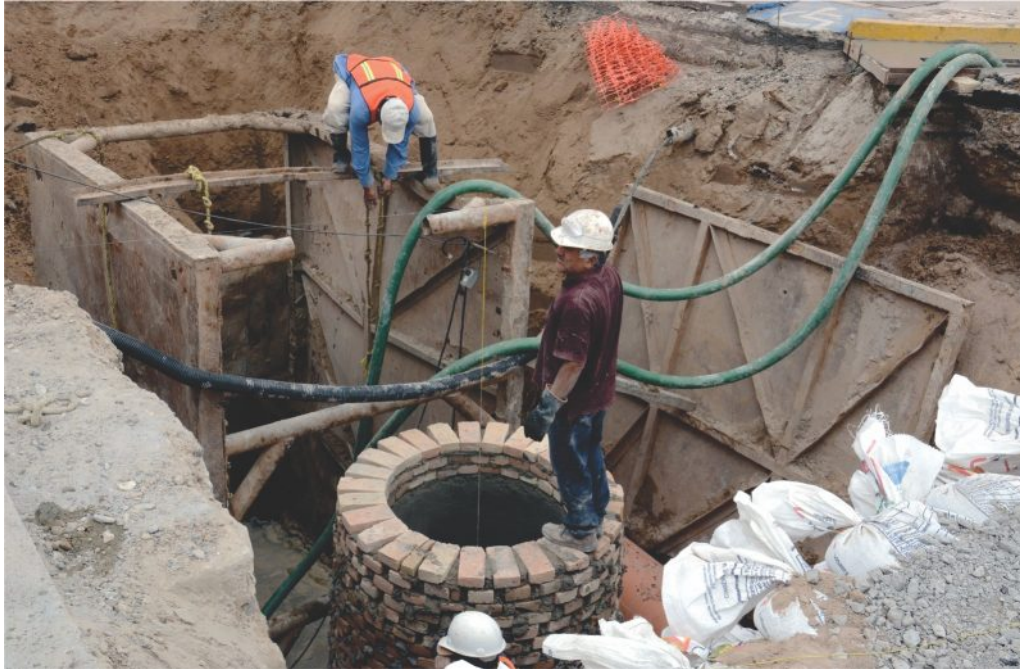
En Nuevo Laredo se invierte en sanear el agua, por ello se realizan obras de rehabilitación de colectores.
