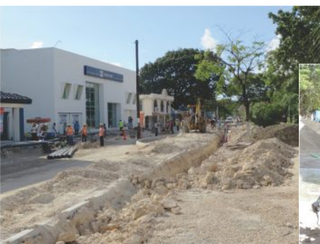
Obras en Av. Tulum.
