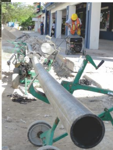
La rehabilitación de 1,922 metros de tubería de agua potable.
