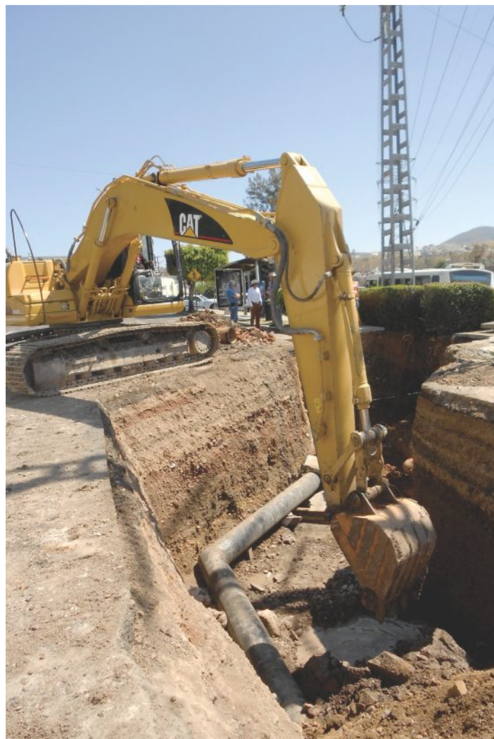
OOAPAS trabaja por el mejoramiento de la red de distribución de agua.
