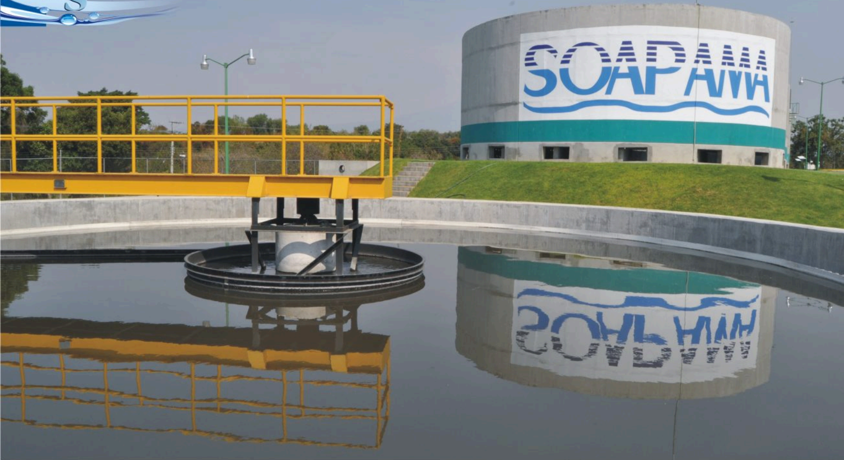
Planta de tratamiento de Atlixco, Puebla.
