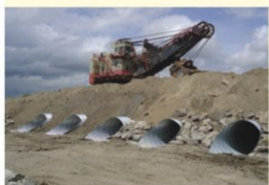
Tubería de metal corrugado para alcantarillas
