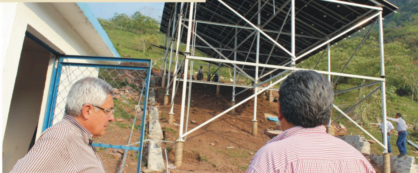
Instalación de un sistema de bombeo de agua mediante energía solar.
