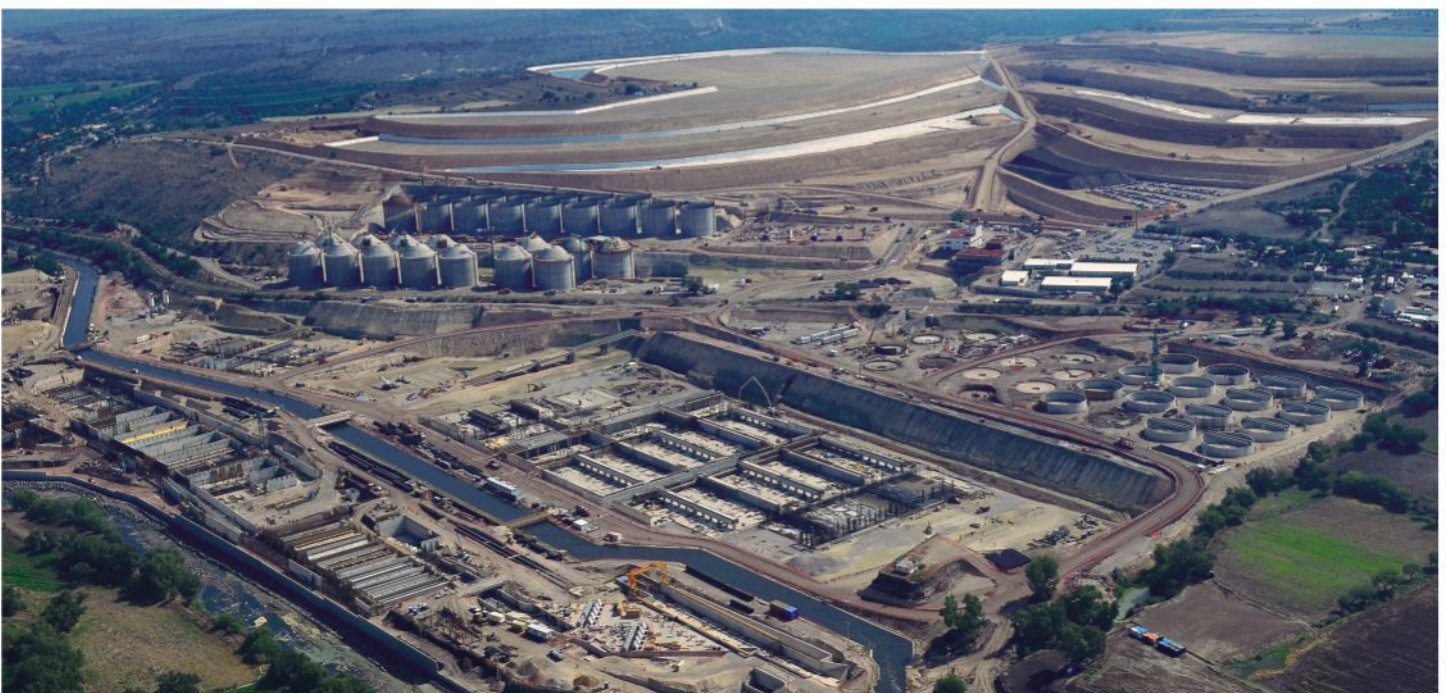
Planta de tratamiento de aguas residuales de Atotonilco.
