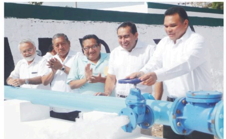
Gobernador Rolando Zapata Bello inauguró dichas obras hidráulicas.
