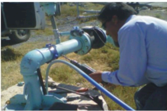
Instalación de equipos y dispositivos de cloración.
