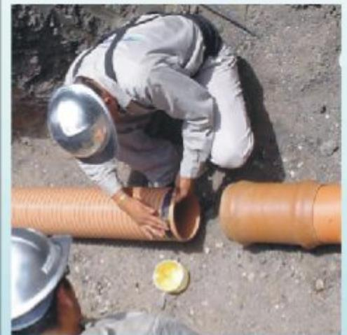
De acuerdo con el tipo y nivel de compactación del material de relleno, el **Tubosistema Novafort** puede instalarse en zonas urbanas a profundidades mínimas de hasta 0.21 m y máximas que superan los 11 metros de profundidad a la corona del tubo.
