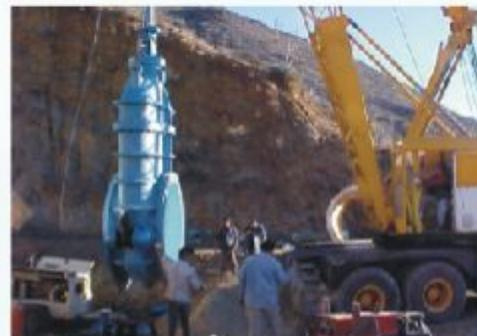
Instalación de válvulas de compuerta de 48" AVK Glenfield en el sitio de la obra.
