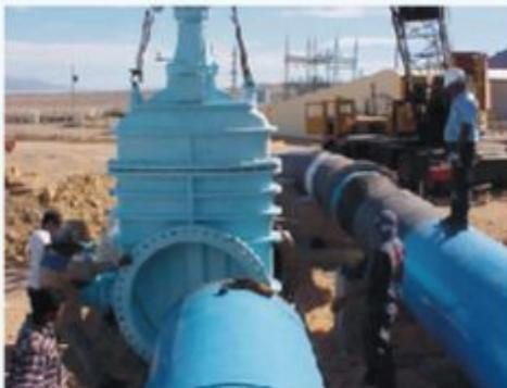
aplicación de presión hidrostática al cuerpo de la válvula hasta dos veces su clasificación de presión, así como una prueba de sellado a presión diferencial completa permitiendo una fuga máxima de 1.2 mL por pulgada de diámetro por hora. Todas las pruebas fueron cuidadosamente inspeccionadas por los funcionarios del Gobierno Mexicano, encontrando resultados exitosos.
