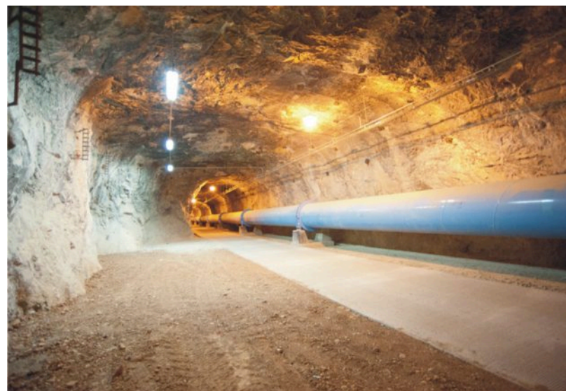
Planta de bombeo.
