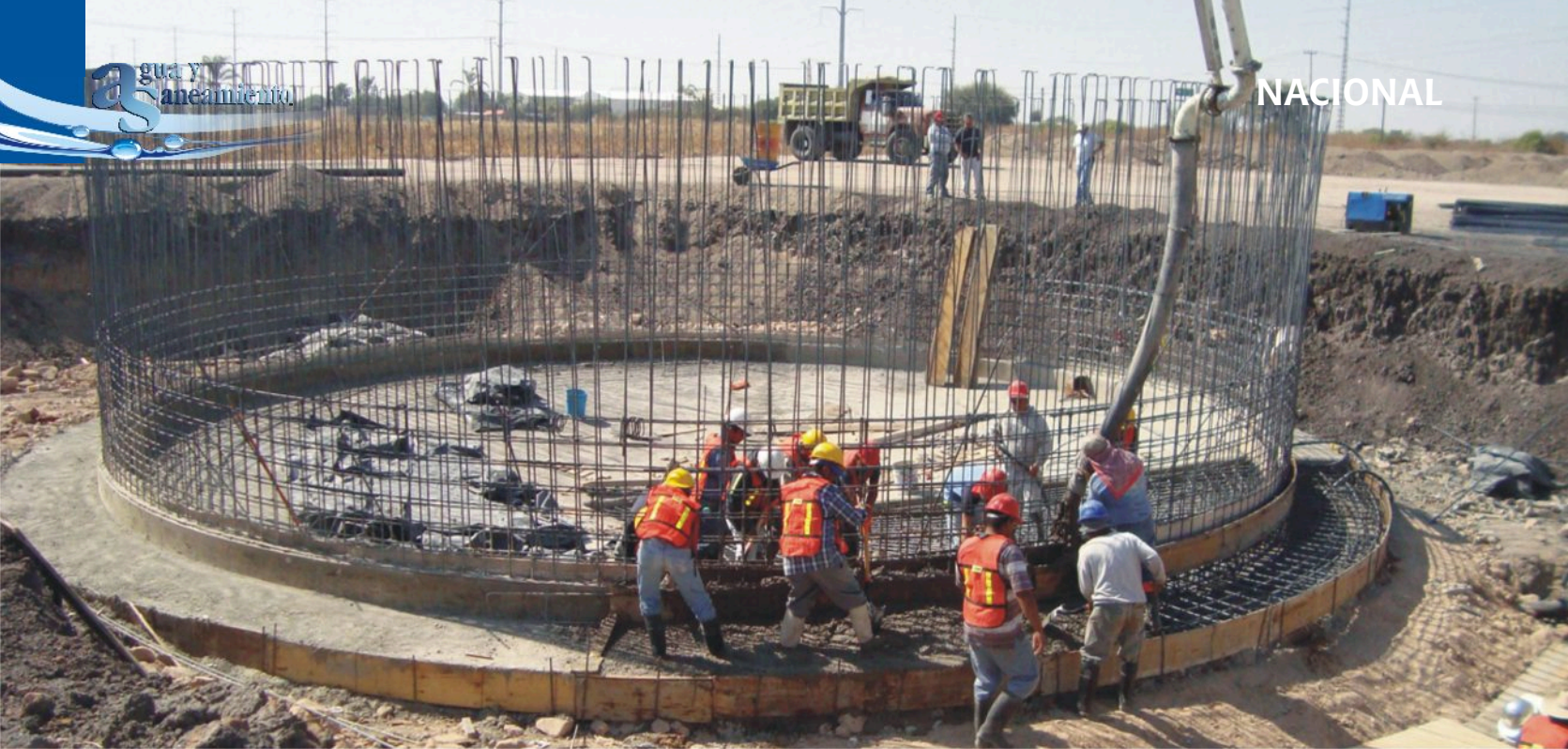
Se ejecuta la construcción de tanques superficiales y elevados para agua potable y líneas de conducción.
