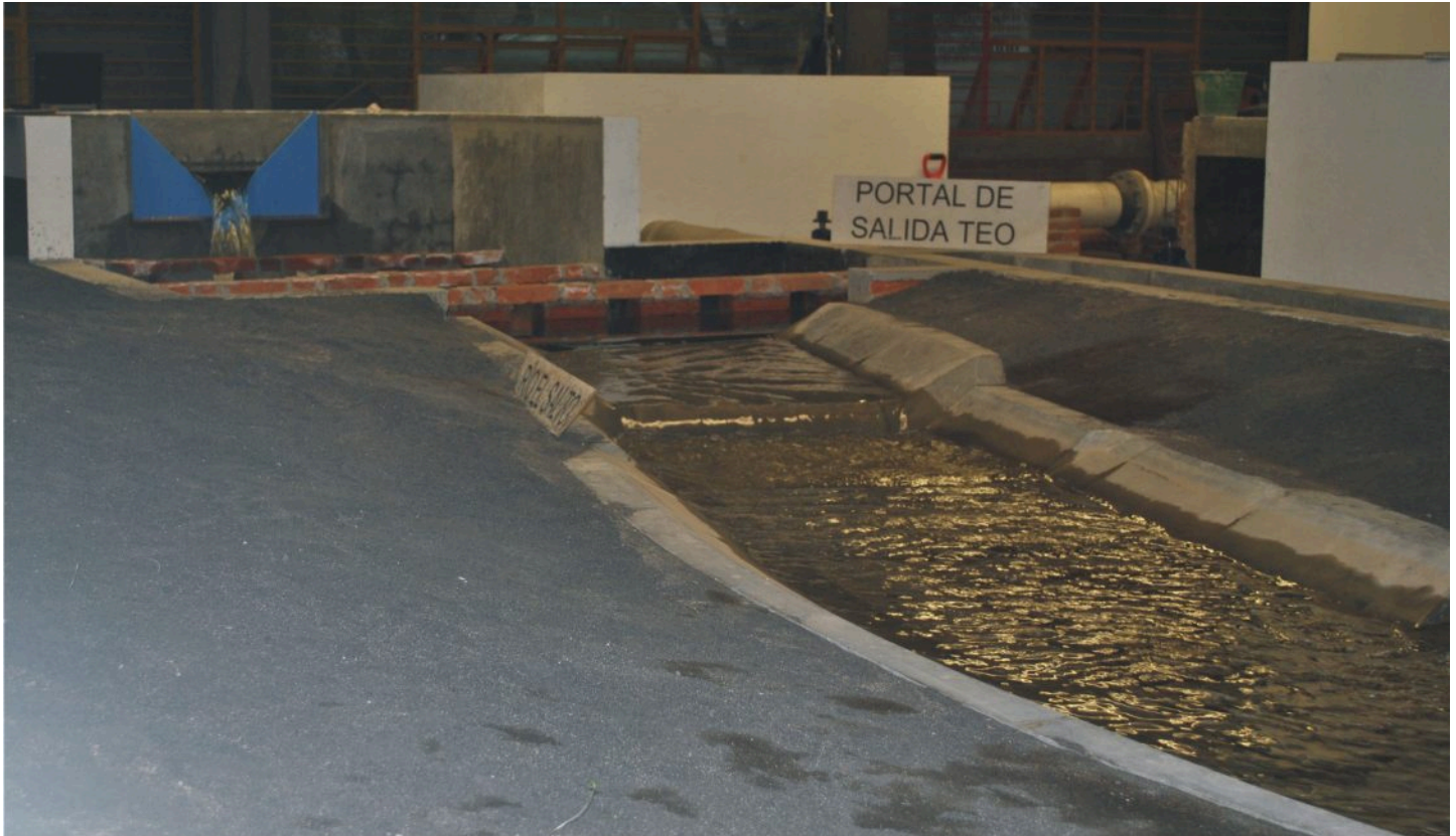
Modelo del Túnel Emisor Oriente en el Instituto de Ingeniería de la UNAM.
