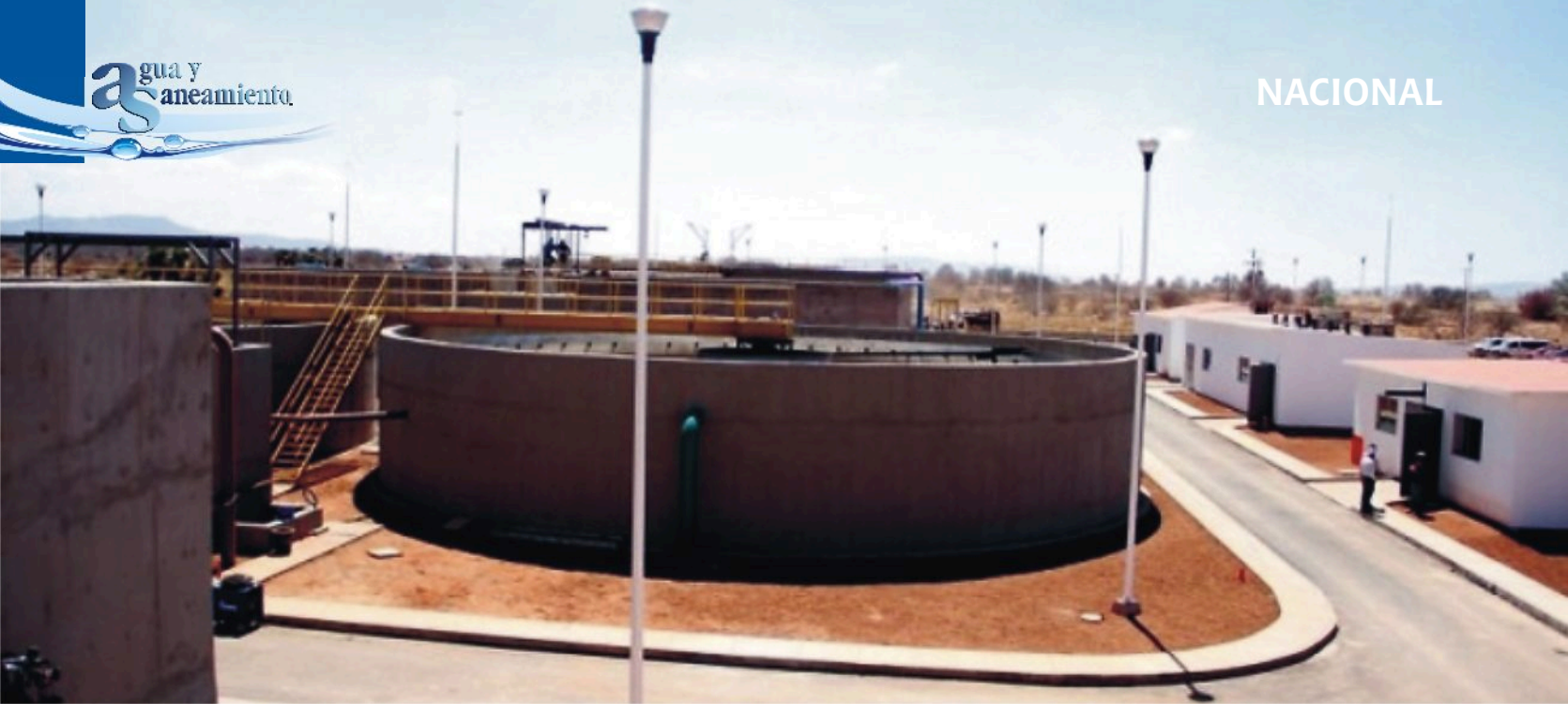
La planta de aguas residuales de la Zona Poniente Zacatecas - Guadalupe es la más grande del estado, tiene una capacidad máxima de procesamiento de 160 litros por segundo.
