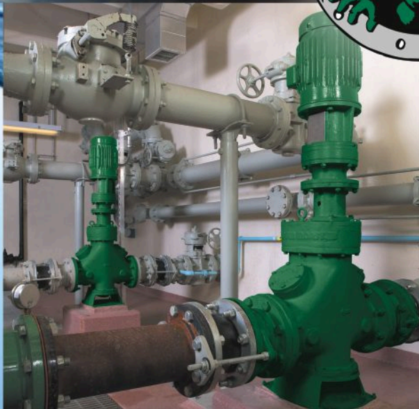
Muffin Monster® Trituradora para estación de bombeo
