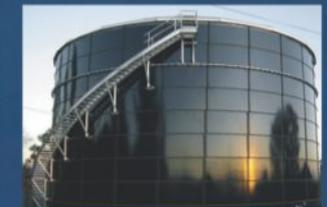
Proceso de 3 capas de revestimiento 1 fusión, ÚNICO EN EL MERCADO que ofrece una capa adicional de Dióxido de Titanio (TiO<sub>2</sub>) incrementando el espesor de revestimiento a 18 mils e incrementando la vida útil a más de 50 años
