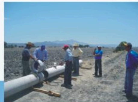
Capacitación por parte del personal Técnico de campo al personal de la Constructora que se hará cargo de la instalación del producto.
