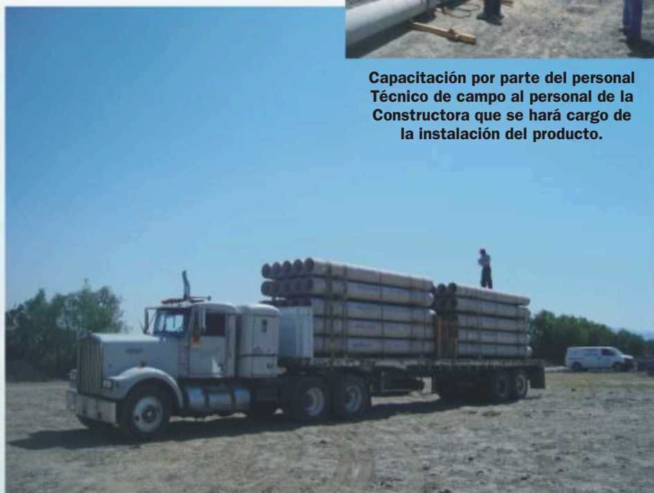
Llegada del material a la obra de Palma Gorda, Hgo.
