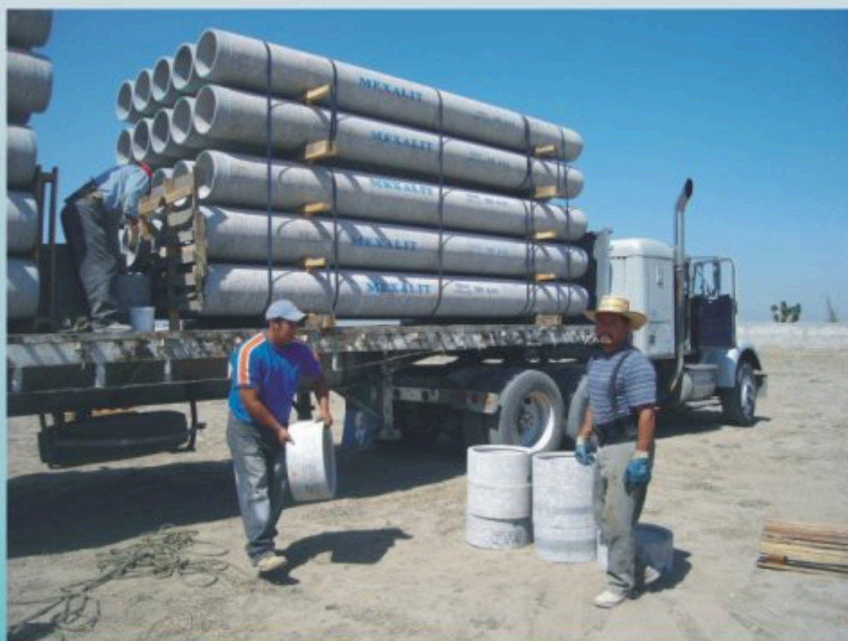
Descarga del material en obra.
