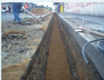
Foto 3. Ampliación de red de 4”.
