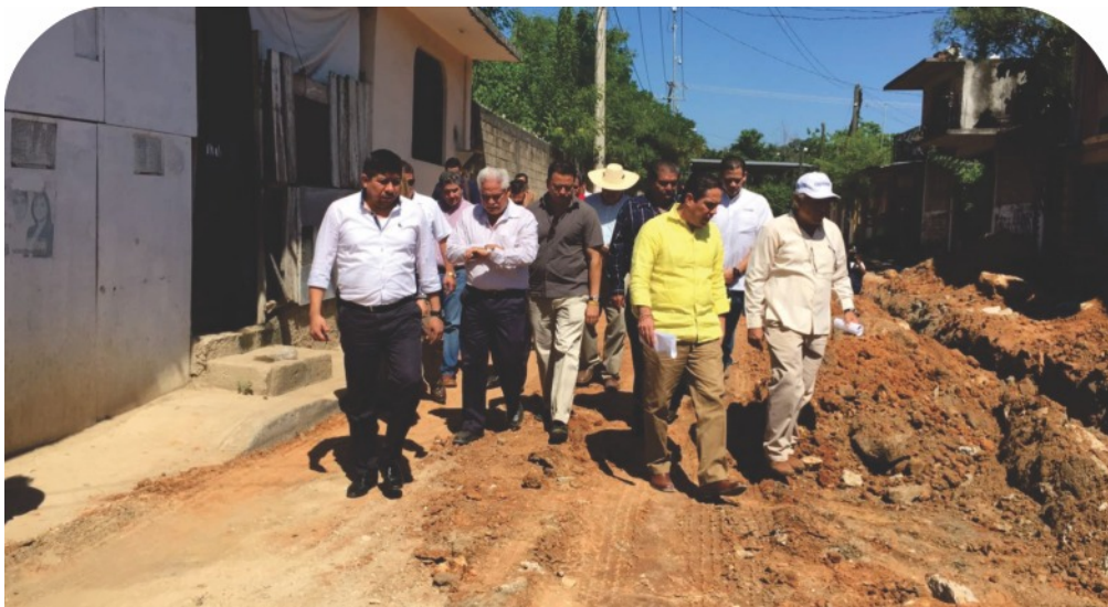
Construcción de la línea de conducción de agua potable del rebombeo Venta-Zapata al Tanque Sinaí.
