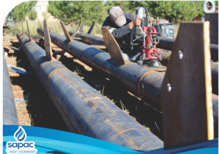
Calera construye el pozo número 8 para beneficiar a los usuarios.
