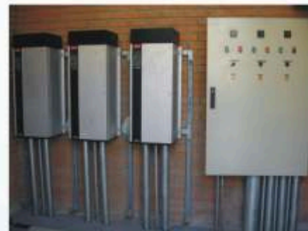
Instalación Maestro-Esclavo en salida a ramales
