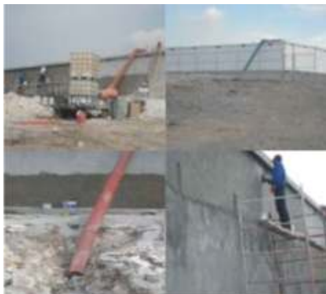
Figura 4. Rehabilitación del Tanque Burócratas que abastecerá el Sector Hidráulico 3 (SH3)
