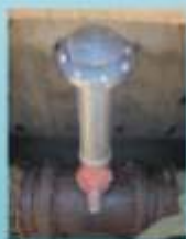
Válvula de aire AVK con amortiguador anti-golpe y cuerpo de acero inoxidable
