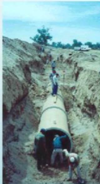
● **Tubería para alcantarillado con junta hermética Clase B**
