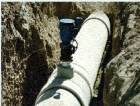
**ICHSA Lock Joint** fue la primera compañía en México en producir **tubería de concreto presforzado** empleando la **tecnología lock joint** de amplia trayectoria a escala mundial.
