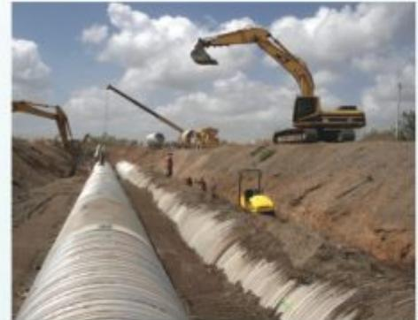
Tubo **ULTRA FLO** para alcantarillado pluvial
